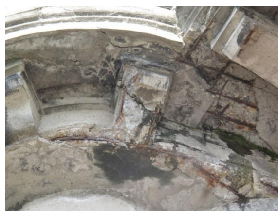
Obrázek 26 – Oprava Palackého mostu
