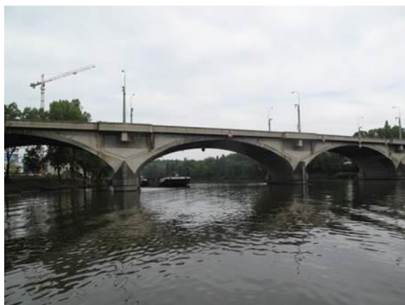
Obrázek 25 – Oprava Libeňského mostu
