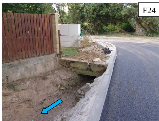
Profil propustku pod silnicí. V budoucnu je plánováno zatrubnění struhy před domy (č.p. 667-455), strouha za domy a zaústění pod silnicí zůstane stejné.
