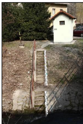
Hlásný profil kategorie A s limnigrafickou stanicí, latí, vyznačenými SPA i výškou poslední povodně.
