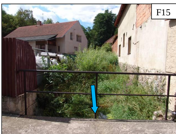
Pohled na koryto Sřebovky proti proudu. Koryto je zde relativně sevřené a zarostlé. V těchto místech se při rozvodnění Výrovky může projevit zpětné vzdutí – pozor na zanášení profilu a ohrožení nemovitostí rozlivem.
