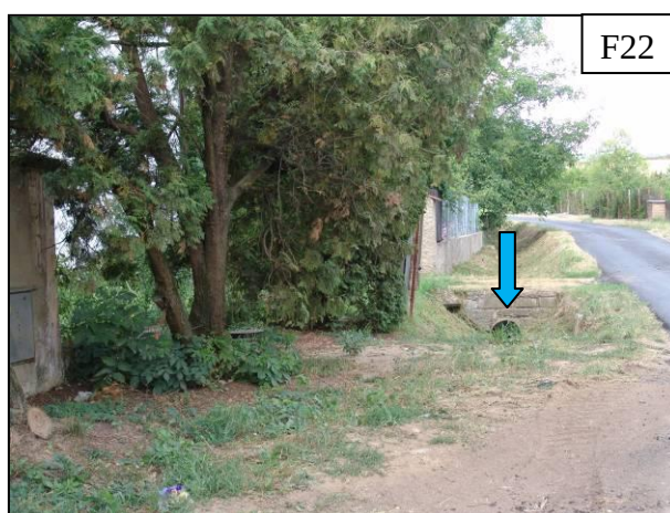
Ze shora kolem domu č.p. 455 přichází i svodnice od úpravny a obě ústí do propustku pod silnicí, za níž pokračuje strouha až do Výrovky – profil i strouha musí být udržovány čisté.
