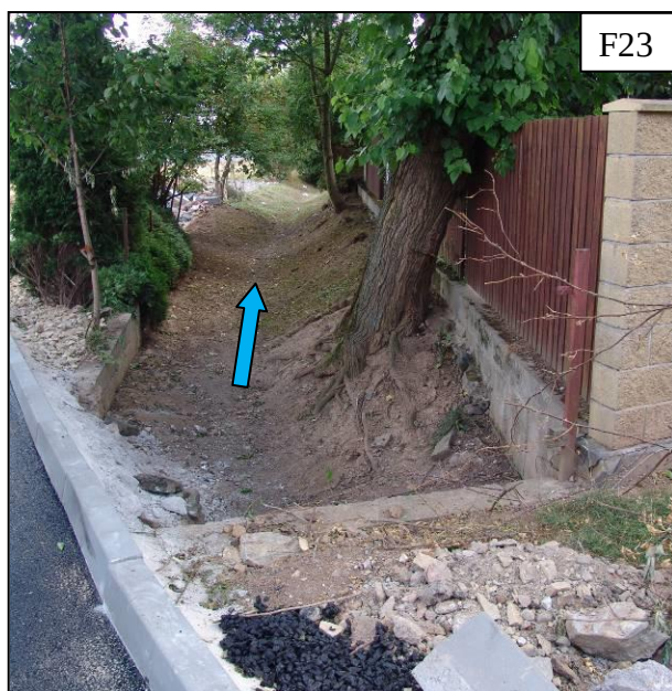
Dešťová strouha za silnicí (u nové ulice) směřuje podél pozemku č.p. 627 k ulici Pražské.
