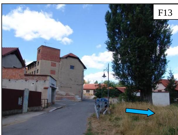
Sřebovka cca 50 m před svým ústím do Výrovky v Podskalí protéká podél domu č.p. 576, u něhož je na toku poslední mostek.
