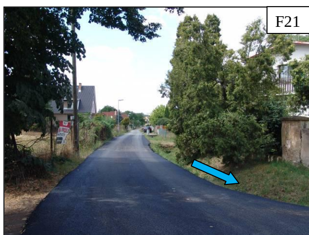
Pohled do ulice Okružní od č.p. 455 směrem k zahrádkám a úpravně vody. Po pravé straně před domy vede odvodňovací strouha.
