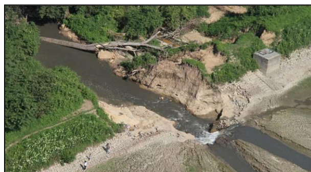
Protržená hráz rybníka Strašík měsíc po povodni.
