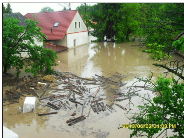
Pohled na zadní stranu domů č.p. 386 a 219 v ul. Kolínská 2.6. 2013 – kolem kulminace povodně.
