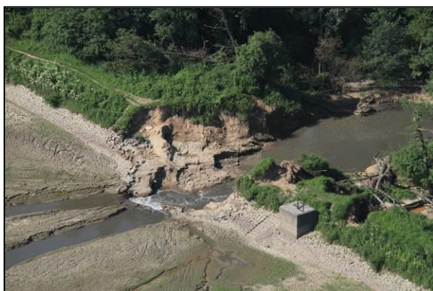
Protržená hráz rybníka Strašík měsíc po povodni.
