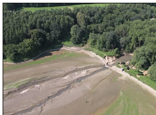
Letecký pohled na rybník Strašák směrem od hráze v únoru 2015 – současný stav (vlevo) a směrem k bezpečnostnímu přelivu a protržené hrázi v roce 2013 po povodni (vpravo).
