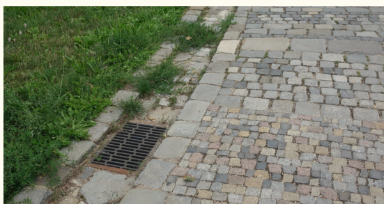
Povrchové odvádění dlážděným žlabem do vsaku Brno – ulice Udolní
