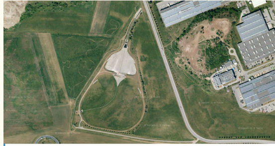
Suchá retenční nádrž průmyslové zóny Brno – Černovická terasa (© Mapy.cz)
