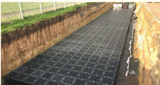
Vsakovací rýha z plastových boxů Výrobce MEA Water Management (© MEA WM)
