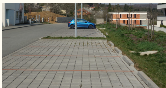
Distanční dlažba a odtok do vsakovacího průlehu Brno – obytný soubor Panorama
