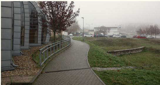
Vsakovací retenční nádrže objektu bazénu Brno – plavecký bazén v Kohoutovicích
