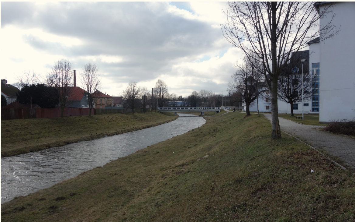
Koryto řeky na území Krnova je udržováno ve stálé trase, regulační práce proběhly v roce 1919. Krnov – nábřeží Opavy u mostu při ulici U Jatek
