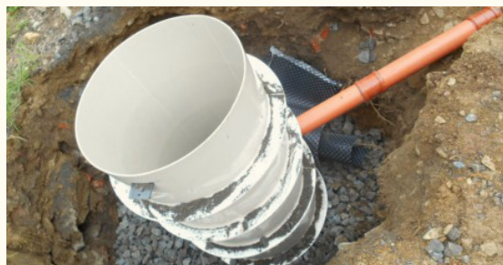
Plastová vsakovací šachta Výrobce Asio (© Stavby Graw)
