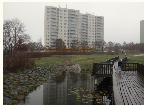
Viditelné odvádění s dešťovými srážkami ze střech z panelových domů vytváří nový atraktivní veřejný prostor v jejich okolí. Brno – Pod Plachtami, nádrž se zásobním prostorem
