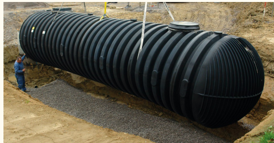
Plastové retenční nádrže mají objemy desítek m 3 Výrobce Elkoplast (© Elkoplast)
