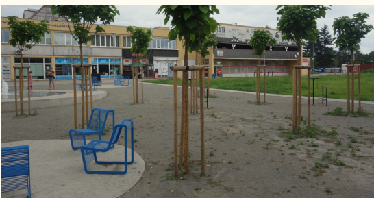
Srážky z náměstí jsou sbírány do nádrží k závlaze Brno – Juliánovské náměstí
