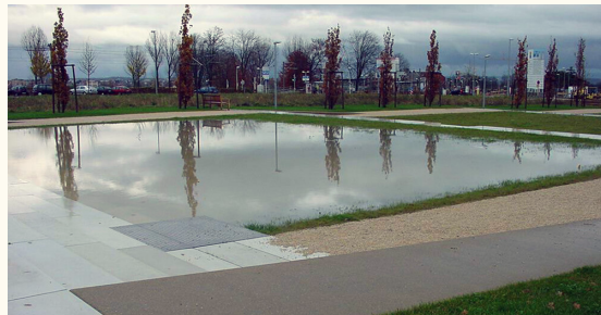
Vsakovací retenční nádrže nové čtvrtě Ostfildern – Scharnhauser Park (© Dreiseitl)
