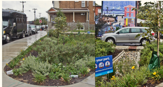
Osázený vsakovací průleh, tzv. Rain garden Filadelfie – Sedgley Av. (© Kimberly Paynter)
