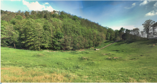
Suchá nádrž je součástí protipovodňové ochrany Brno – Komínský potok
