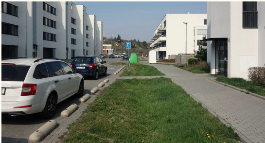
Travní vsakovací průleh odvodňující komunikaci Brno – obytný soubor Panorama
