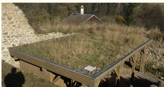
Vegetační střechu může mít velmi malý objekt. Rokštejn – vstupní objekt
