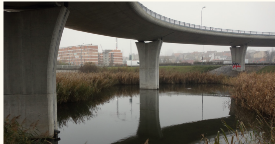
Velkokapacitní retenční nádrž se stálou hladinou Brno – Červený mlyn
