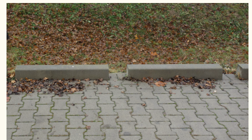
I jednoduché odvodnění drážkou v obrubníku má smysl Brno – kampus MUNI
