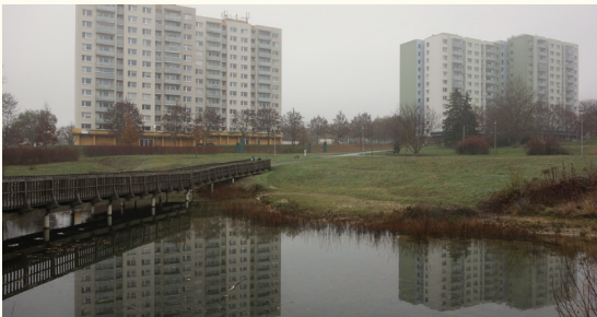
Střešní srážky z protějších domů jsou zachycovány Brno – Pod Plachtami, nádrž se zásobním prostorem
