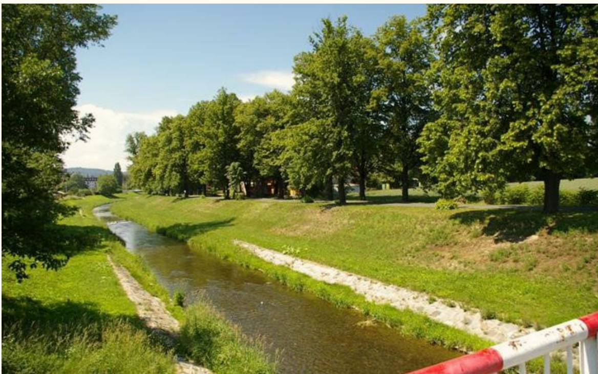
3km úsek řeky Opavice, před soutokem s Opavou byl regulován nejdříve v letech 1891, pak 1931–1932. Krnov – nábřeží Opavice z mostu v ulici Hlubčická, před soutokem s Opavou
