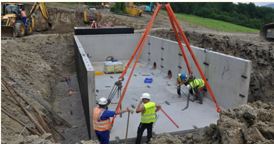
Montované velkoobjemové nádrže z prefabrikátů Výrobce DYWIDAG Aquaschutz (© DYWIDAG)
