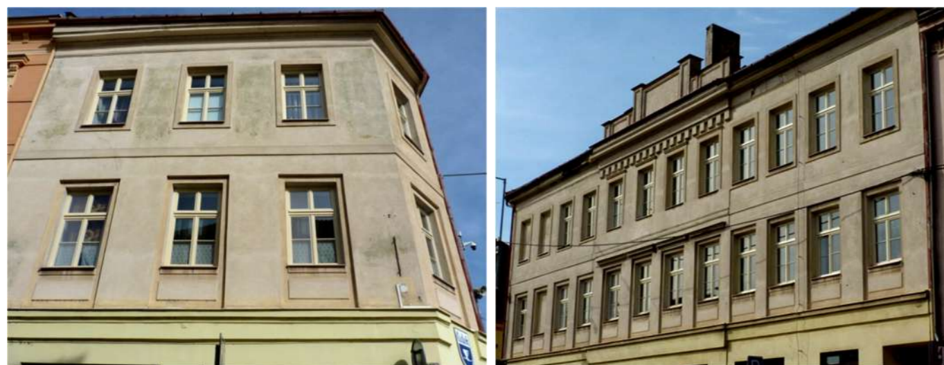
• výměna veškerých oken ve 2. a 3. nadzemním podlaží v nárožním domě na křižovatce ulic Generála Hladě a 28.října (Čedok)
