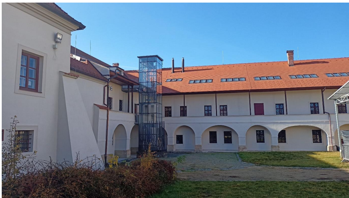
Obr. 8c / Panský dům č. p. 77, dvorní trakt – stav po obnově
