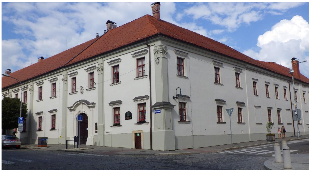
Obr. 8b / Panský dům č. p. 77, uliční pohled – stav po obnově
