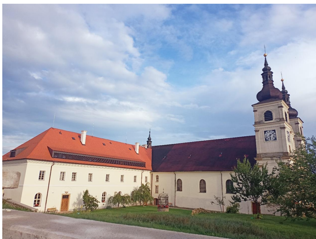
Obr. 10b / Klášter dominikánský – po rekonstrukci
