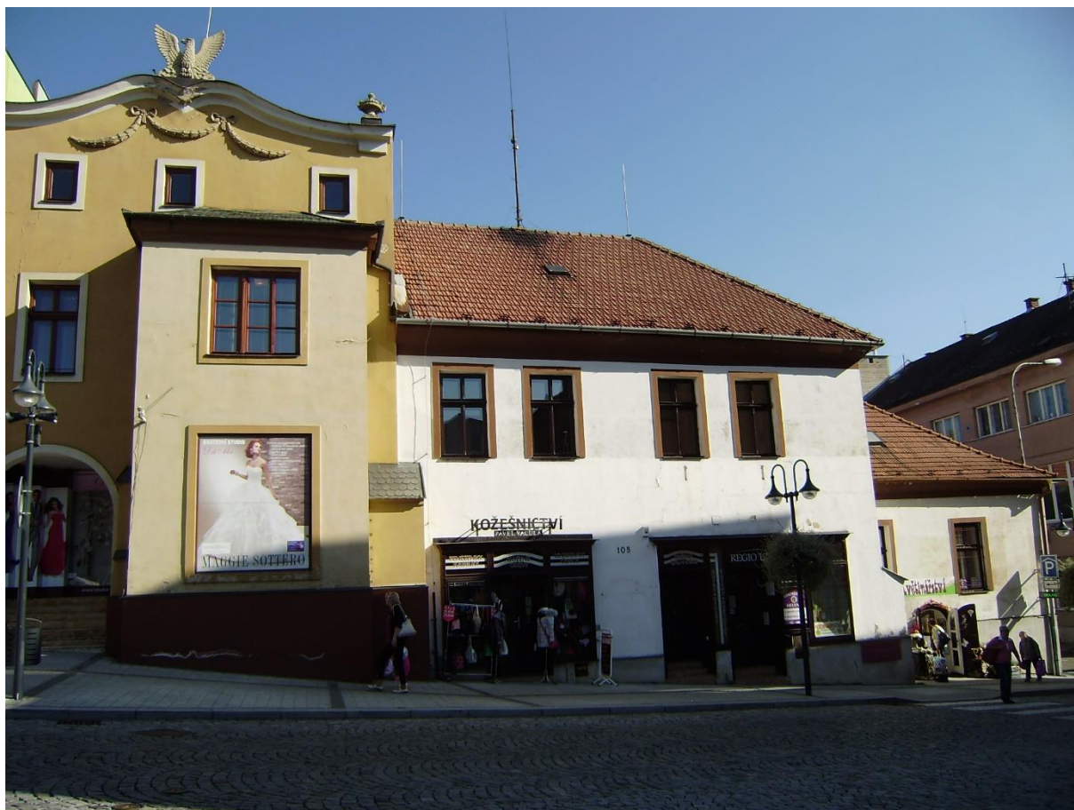
Obr. 9a / Městský dům č. p. 105 a č. p. 104 - původní stav
