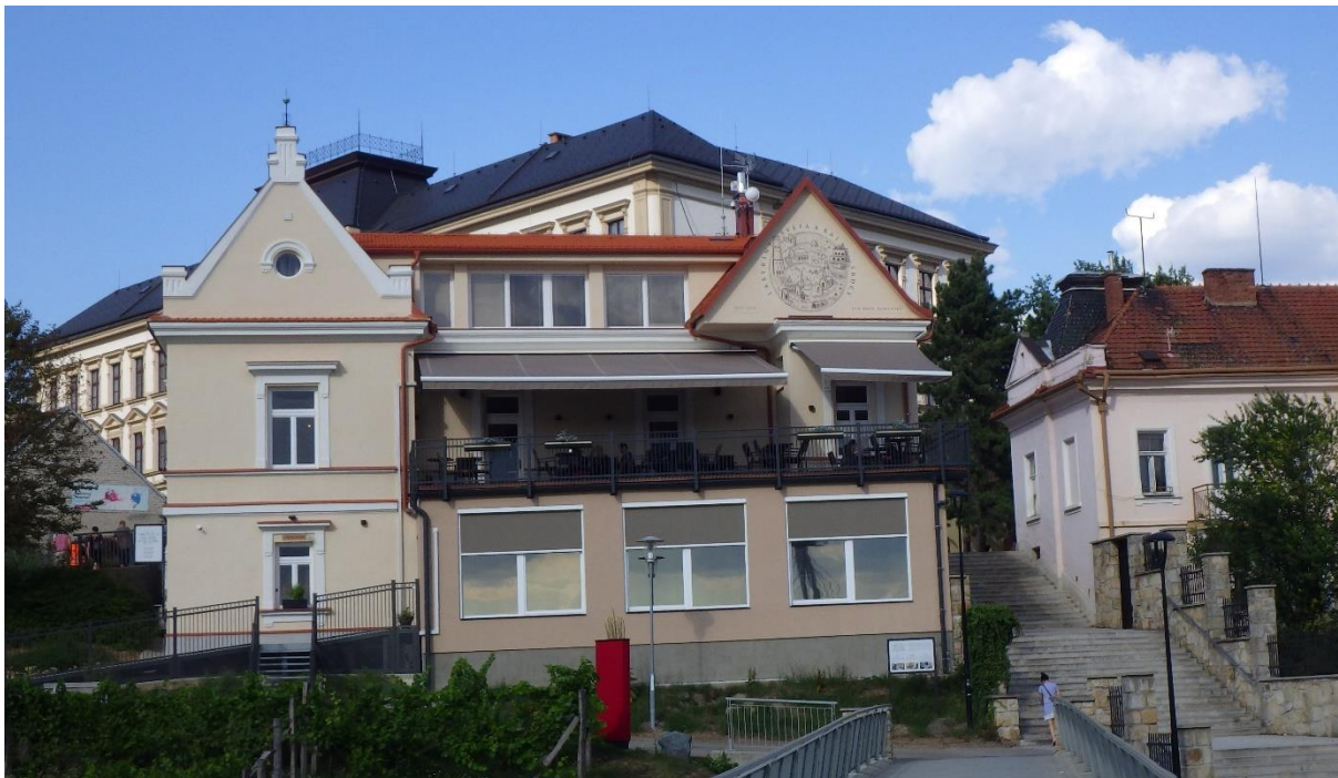
Obr. 15 / Nově rekonstruovaná budova čp. 496 na okraji MPZ před budovou gymnázia
