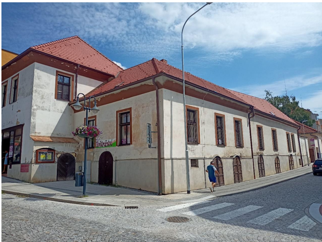
Obr. 9c / Městský dům č. p. 105 - před obnovou fasády
