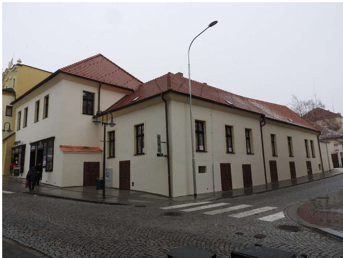
Obr. 9d / Městský dům č. p. 105 - po obnově fasády
