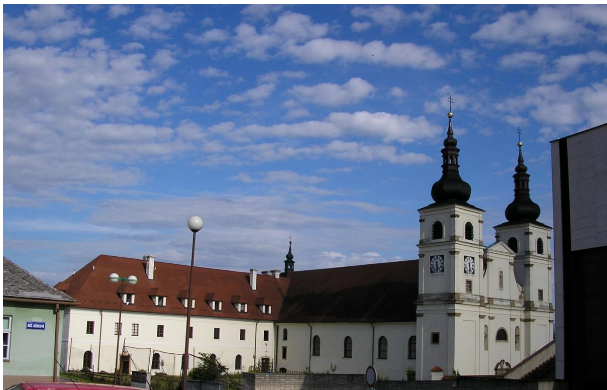
Obr. 10a / Klášter dominikánský – před rekonstrukcí
