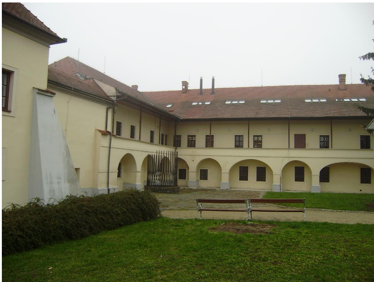
Obr. 8c / Panský dům č. p. 77, dvorní trakt – původní stav
