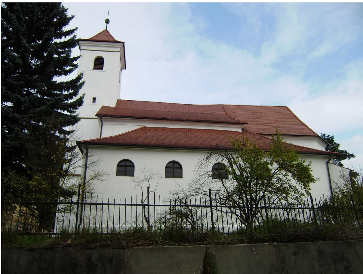
Obr. 19a / Kostel Mistra Jana Husa – současný stav okolí vyžadující úpravy
