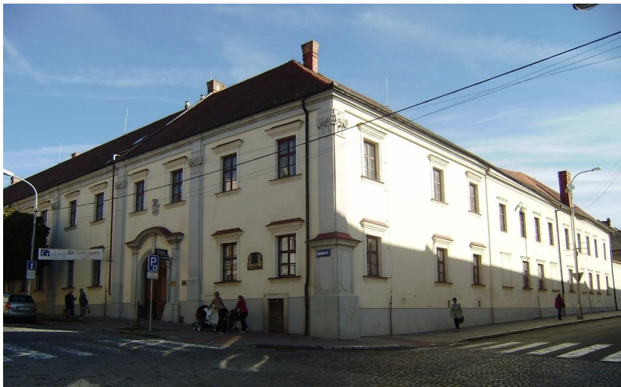
Obr. 8a / Panský dům č. p. 77, uliční pohled – původní stav
