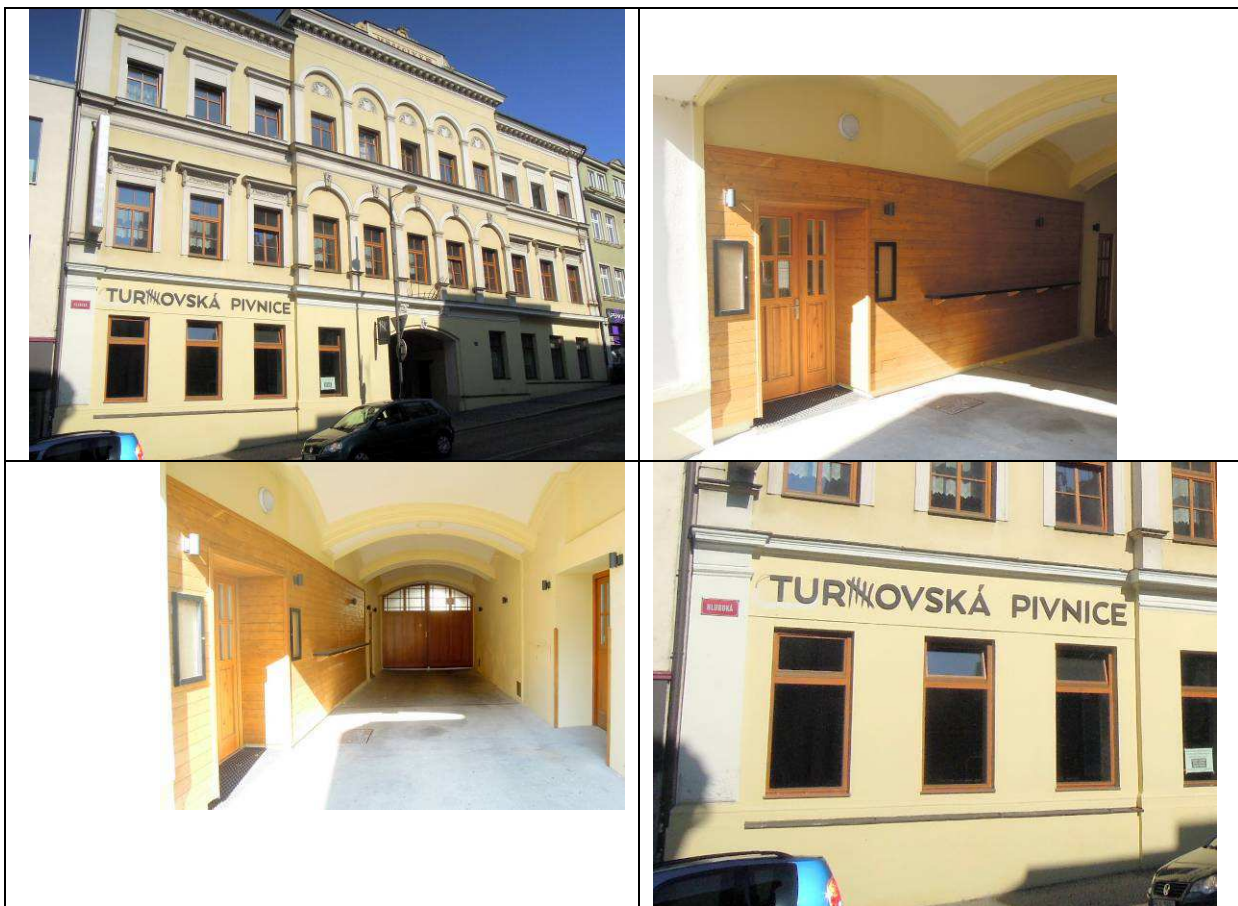
Celková rekonstrukce čp.146 v Hlubocké ulici. Kvalitně provedená oprava parteru včetně decentního označení provozovny.
