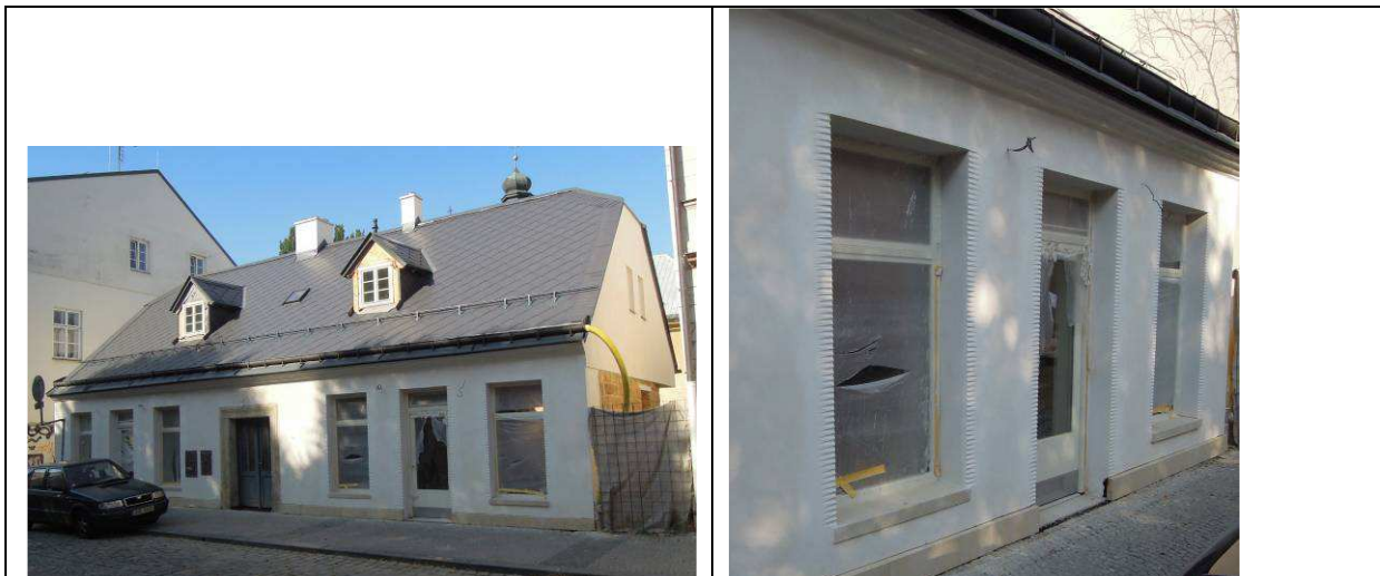
Jednoduchá, vkusná oprava fasády čp. 82 ve Skálově ulici – doplněno prolamovaným rámováním výkladců.
