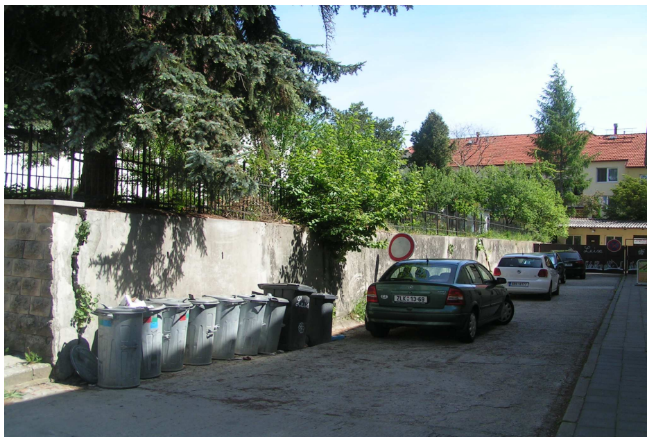
Kostel mistra Jana Husa – opěrná zeď u Nadačního domu (současný stav).
