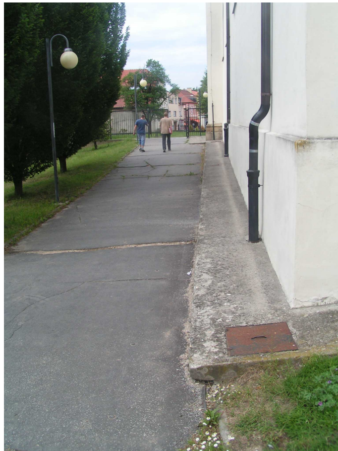
Kostel Nanebevzetí Panny Marie – chodník s živičným povrchem (současný stav).
