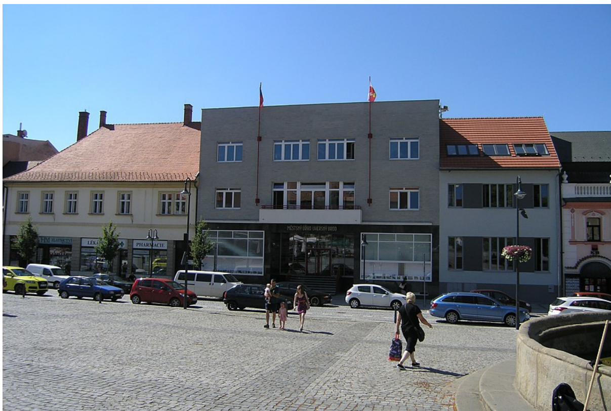
Obr. 12a / Nově opravené fasády na Masarykově náměstí
