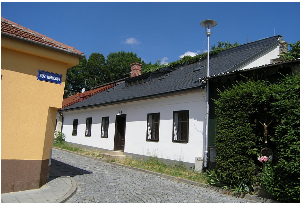
Obr. 7b / Městský dům č.p. 220, památka lidové architektury – stav po rekonstrukci
