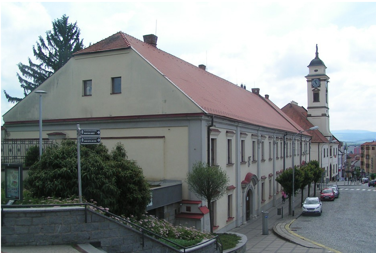
Obr. 11a / Panský dům – část střechy po rekonstrukci
