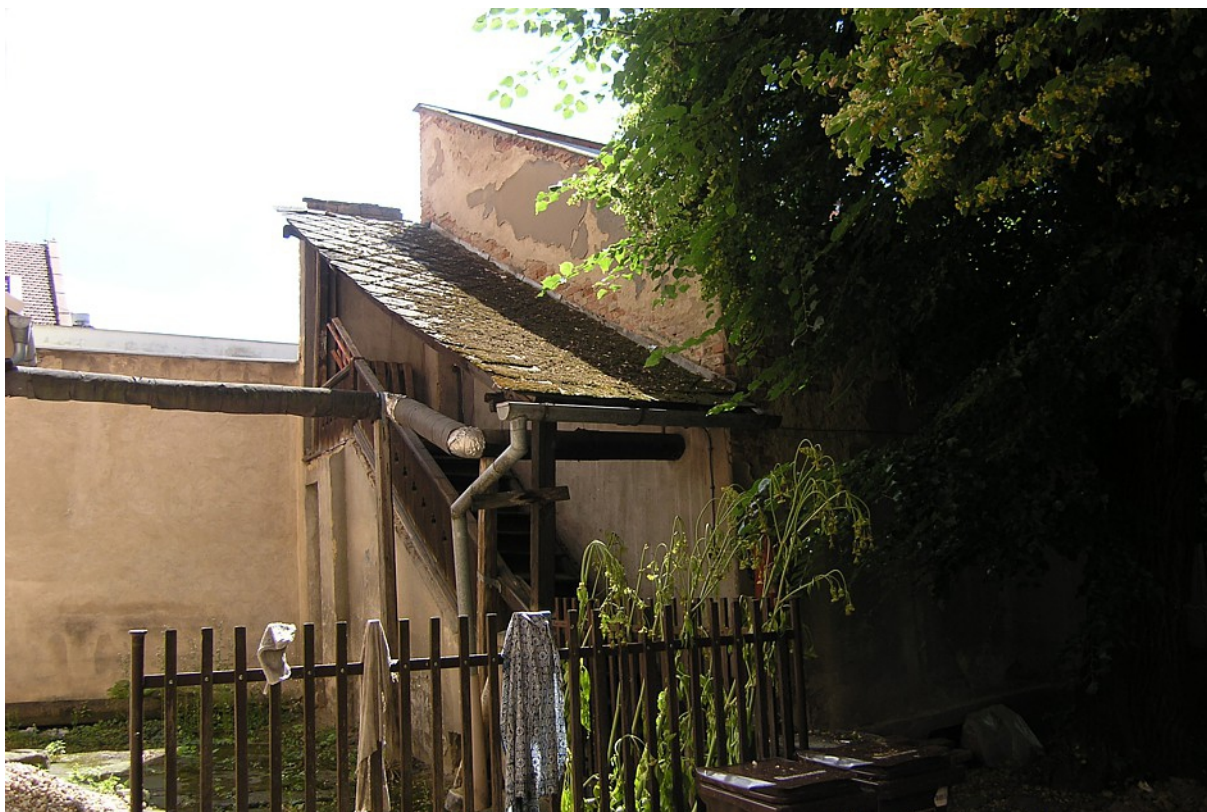
Obr. 8a / Měšťanský dům č.p. 164 – stávající stav dvorního traktu - schodiště
