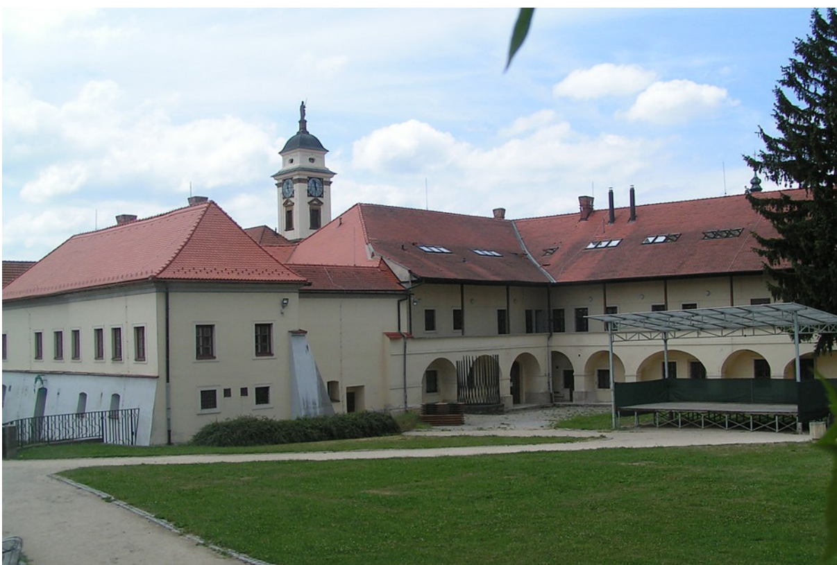
Obr. 11b / Panský dům – nádvoří před rekonstrukcí
