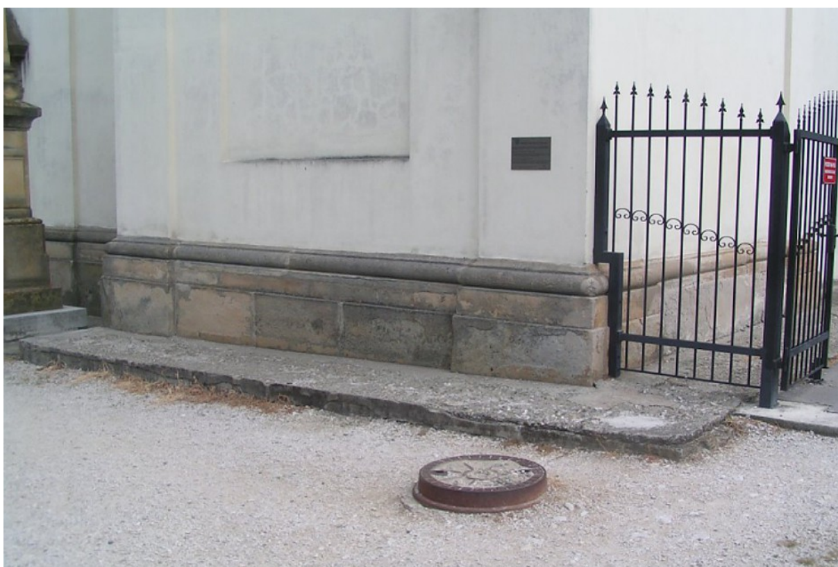
Obr. 17d / Kostel Nanebevzetí Panny Marie – betonový okapový chodník u vstupu do kostela
