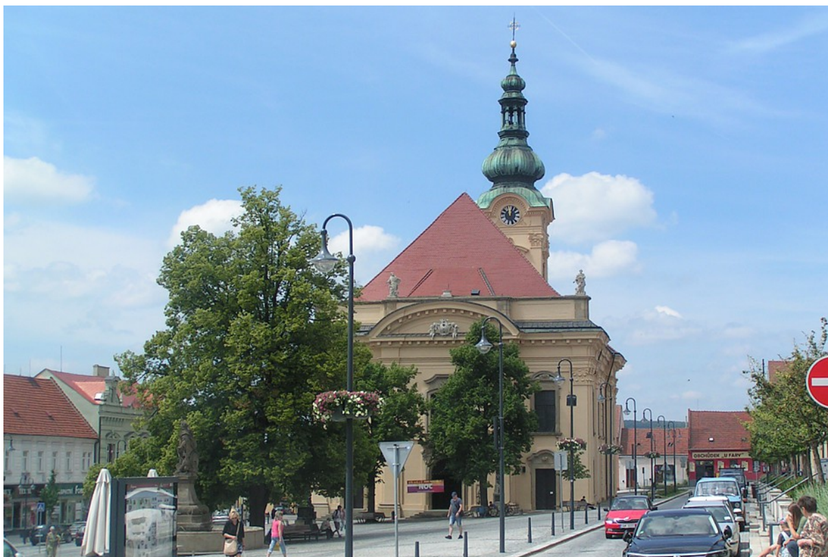
Obr. 10a / Zdařilá rekonstrukce Masarykova náměstí
