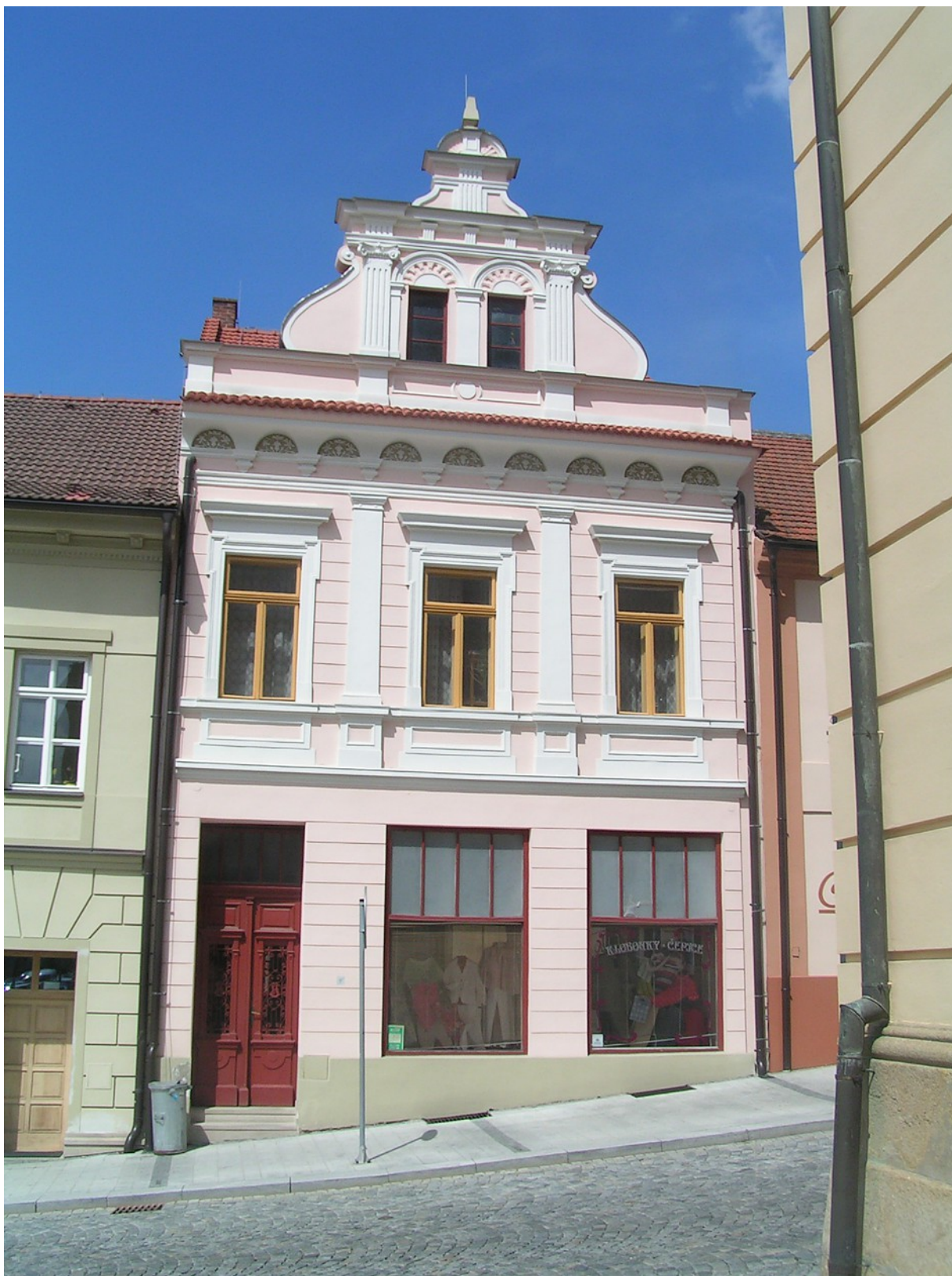
Obr. 13a / Rekonstrukce fasády měšťanského domu č.p. 202
