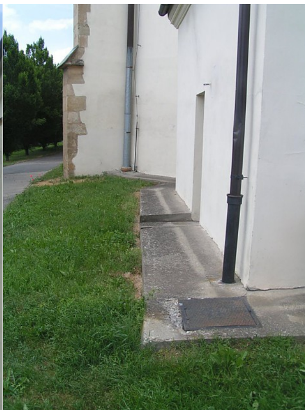
Obr. 17c / Kostel Nanebevzetí Panny Marie okapový chodník
