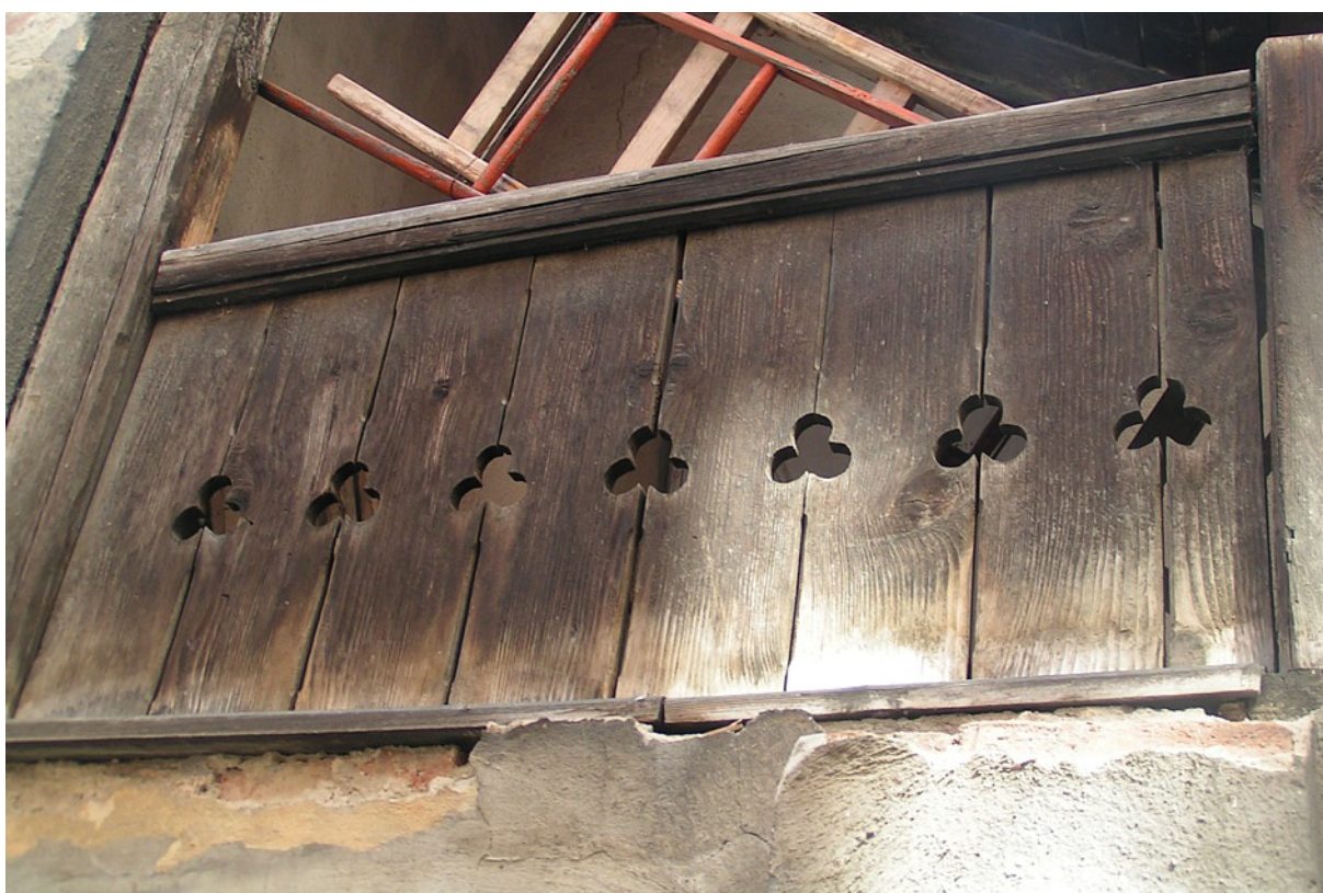
Obr. 8d / Měšťanský dům č.p. 164, dřevěná zábrana u mezipodesty dvorního schodiště
