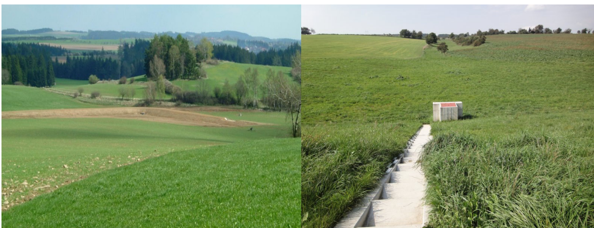
Obr. Těleso hráze suché nádrže se spodní výpustí, vpravo funkční objekt suché nádrže.
