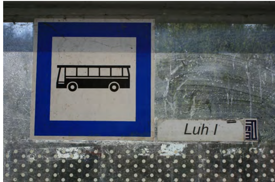
Zrekonstruovaná neudržovaná zast. „Luh I“
