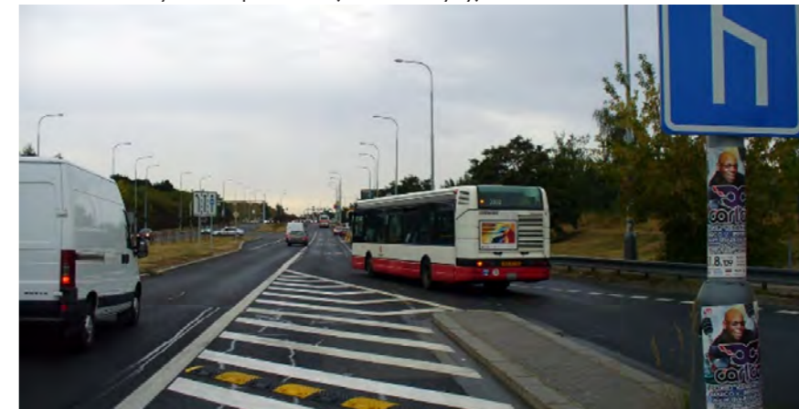
Obrázek: Příklad systémové přednosti v jízdě: chráněný výjezd BUS z terminálu VHD
