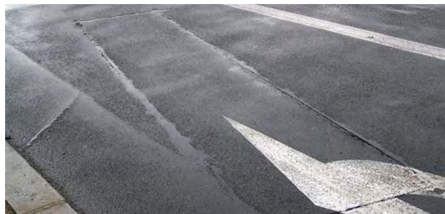
Obrázek: Indukční smyčka v řadicích pružích
