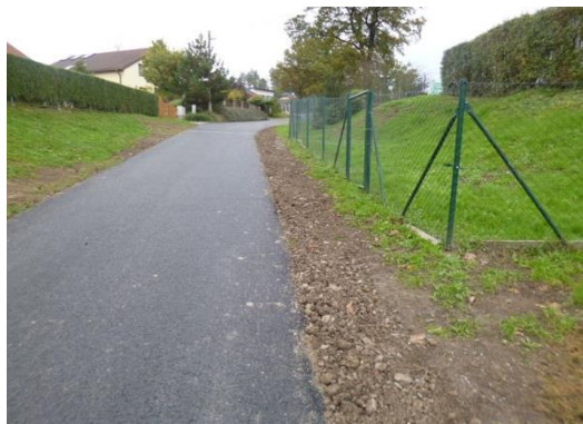
Ulice Na Výsluní (stav po opravě)
