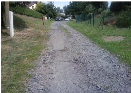
Ulice Na Výsluní (stav před opravou)
