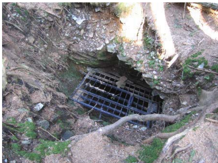
Obrázek č. 42: Zajištění SDD úpadnice štoly Rappolt. Stav IV/2009-05-11
