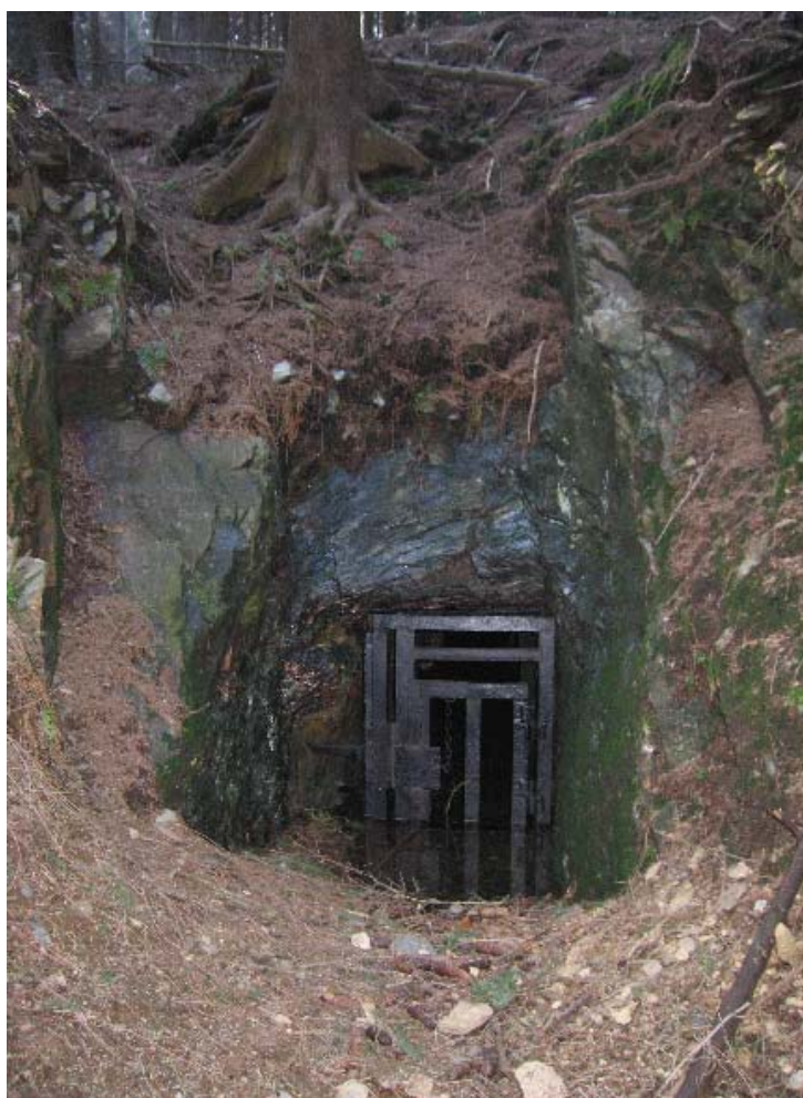
Obrázek č. 44: Zajištěné ústí štoly v revíru Sn rud u Nového Města p. Smrkem (stav IV/2009)
