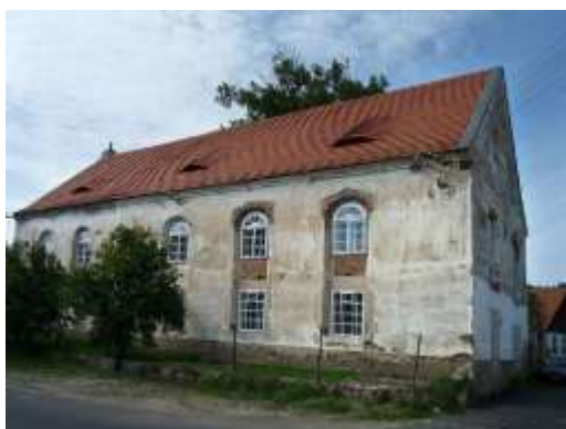
Obrázek 47 Synagoga před rekonstrukcí
