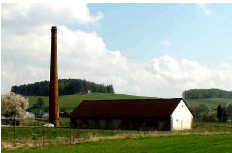
Obrázek 149 zachovaný komín po bývalé cihelně
