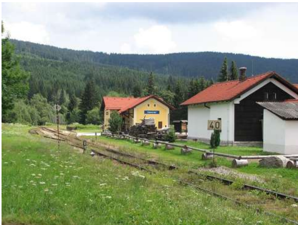
Obrázek 72 Železniční stanice Kubova Huť
