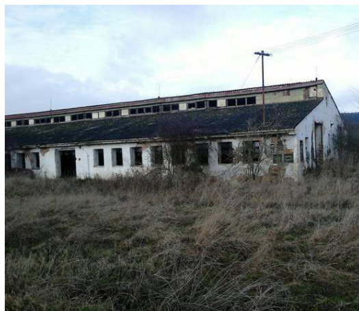
Budova bývalého JZD v Dražkově
