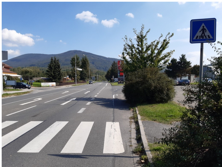
Ul. Radhošťská – přechod u koupaliště není řešen bezbariérově
