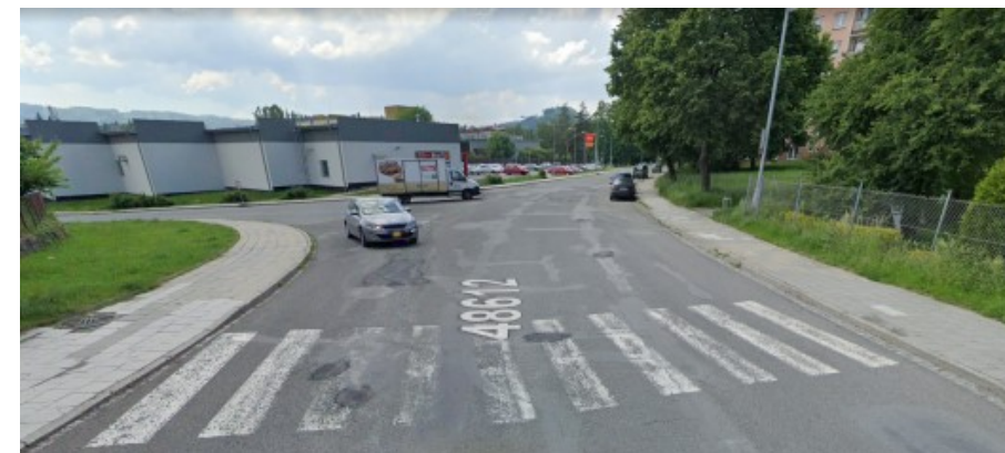
Křižovatka ul. Hradištko / Bezručova (chybí vodorovné dopravní značení)
