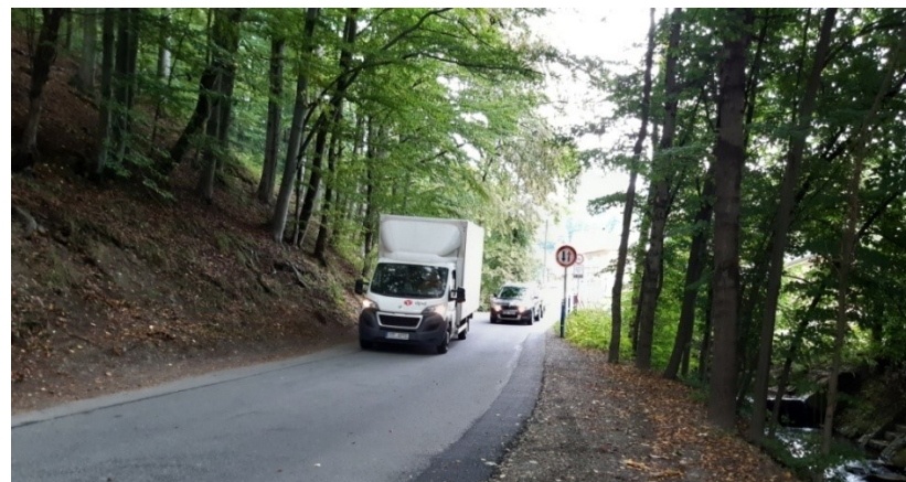
Obrázek 69. Chybějící chodník k mostu přes Vermírovský potok. Foto: ANTE, září 2020
