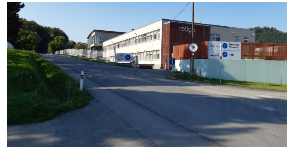
Ul. Videčská, přístup do firmy Retigo – chybí chodník
