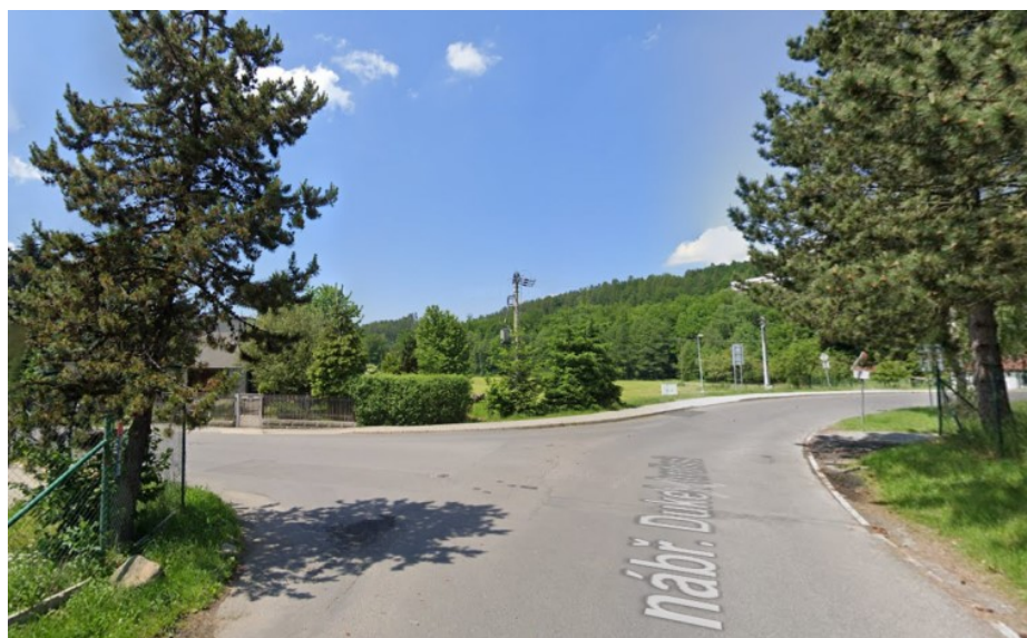
Křižovatka nábr. Dukelských hrdinů a Slezská – chybí chodník a vodorovné dopravní značení
