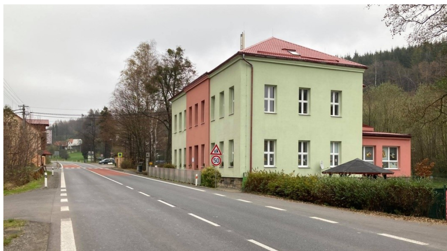
Chybějící chodník v ul. Ostravská u MŠ Horní Paseky 307 (foto: ANTE, září 2020)
