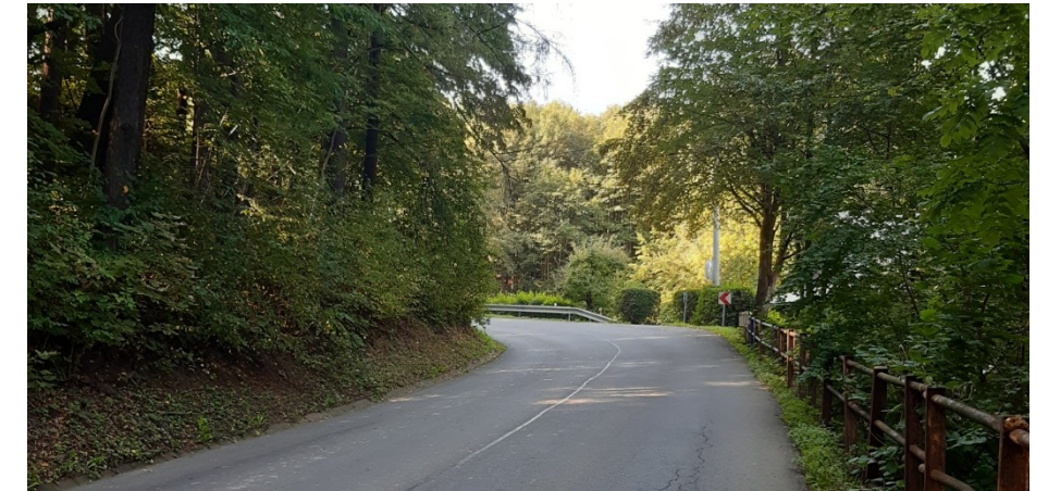
obrázek 28: Videčská ul. - průtah III/4868
