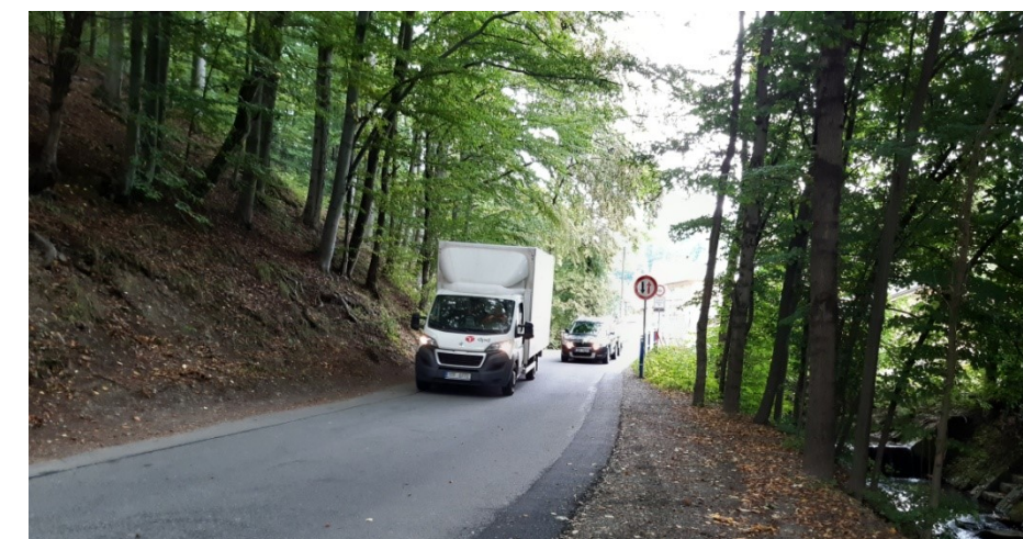
Ul. Dolní Paseky – most přes Vermířovský potok – chybí chodník v ulici Dolní Paseky od křižovatky s ul. Láz (foto: ANTE, září 2020)
