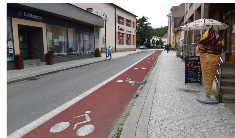
Cykloobousměrka s barevně zvýrazněným cyklopruhem z ul. Palackého na Masarykovo náměstí (foto: ANTE, květen 2020)
