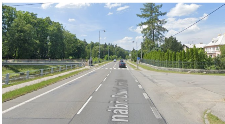
Silnice I/35 u mostu přes Rožnovskou Bečvu u dřevěného městečka – nebezpečný přechod přes hlavní tah s chybějícím ostrůvkem uprostřed
