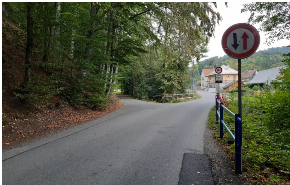
Ul. Dolní Paseky – most přes Vermířovský potok – chybí chodník v ulici Dolní Paseky od křižovatky s ul. Láz
