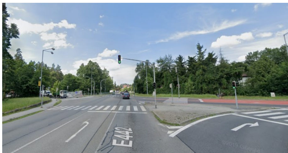
Křižovatka ul. Radhoštská, Palackého, Ostravská (nebezpečné křížení dálkové cyklotrasy č. 46 se silnicí I/35, chybí přejezd pro cyklisty z ul. Radhoštské na ul. Palackého).
