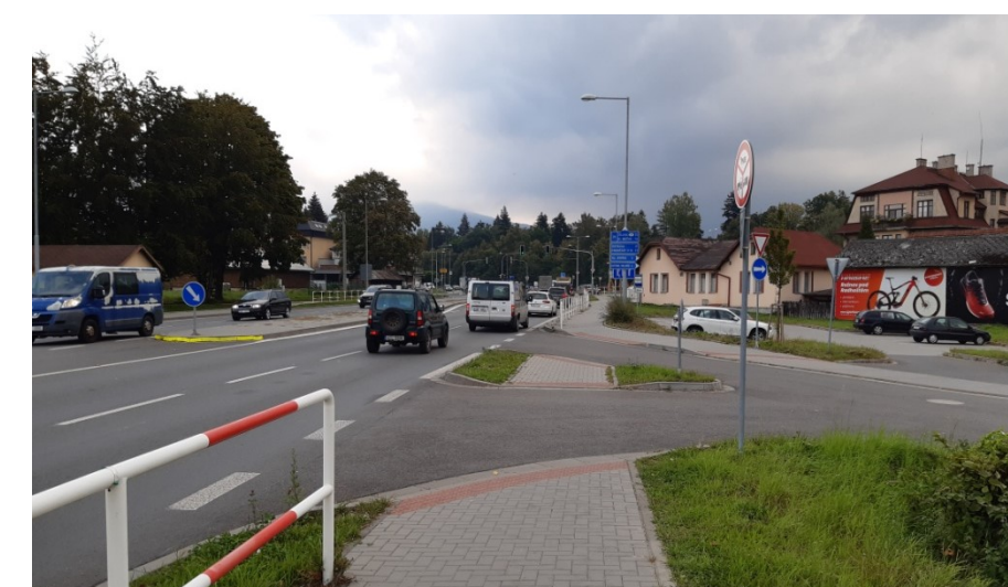
Chybějící přechod na ul. Chodská u autobusového nádraží (zůstal středový ostrůvek)
