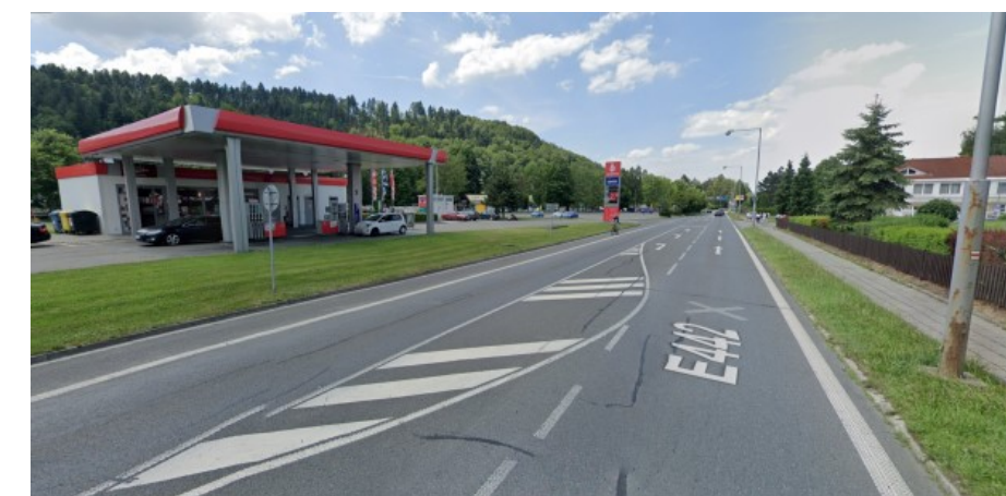
Ul. Radhošťská - dálková cyklotrasa č. 46 vede v úseku od křižovatky ul. Radhošťské se silnicí I/35 po křižovatku ul. Radhošťská a Palackého po frekventované silnici I/35.
