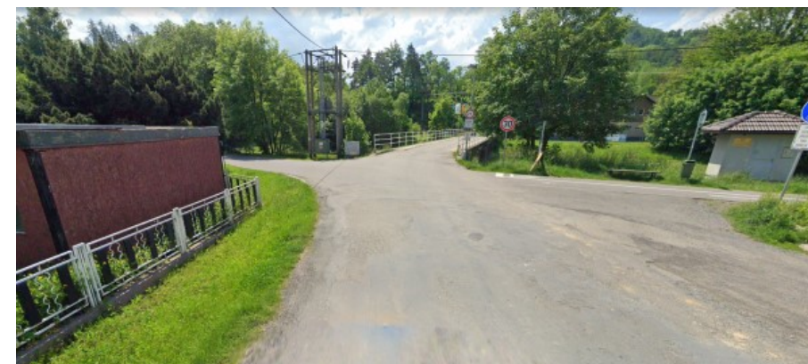
Křižovatka ul. Tyršovo nábřeží (nepřehledná, chybí vodorovné značení)
