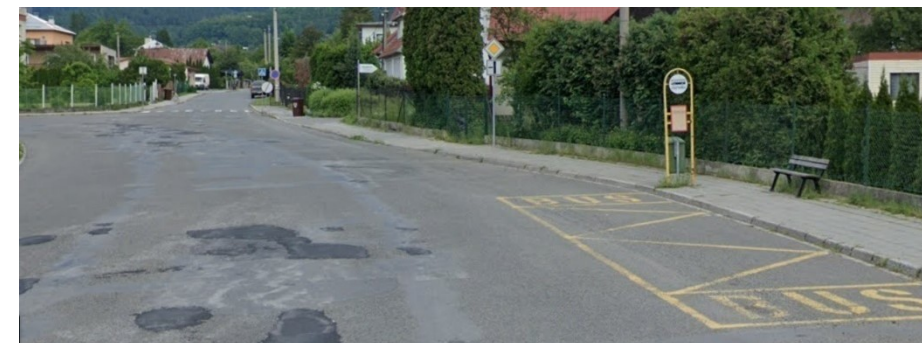
Obrázek 64 Zastávka Dolní Paseky, palírna ve směru na Dolní Paseky, pohled od jihu. Foto: streetview Google, červen 2019.
