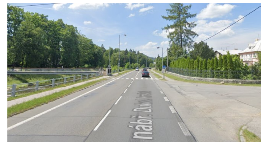
Silnice I/35 u mostu přes Rožnovskou Bečvu u dřevěného městečka – nebezpečný přechod přes hlavní tah s chybějícím ostrůvkem uprostřed
