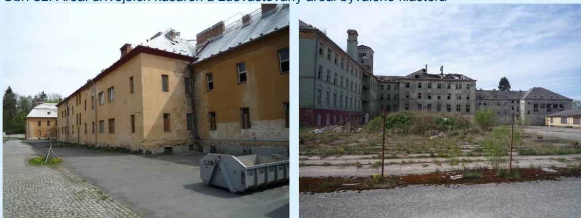
Obr. 31. Areál dřívějších kasáren a zdevastovaný areál bývalého kláštera
