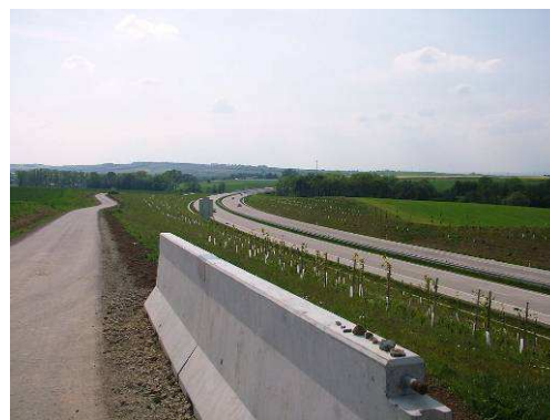
Dokončená dálnice v okolí Bezměrova
