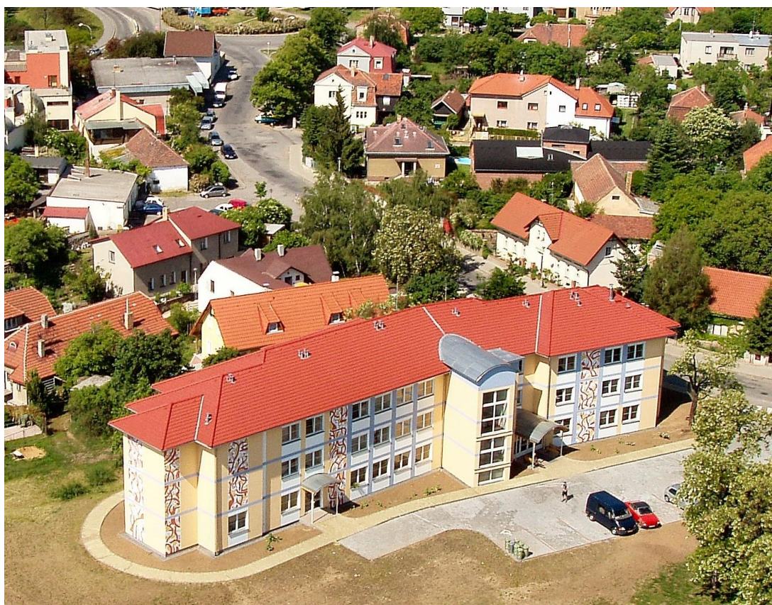
DPS krátce po výstavbě v roce 2004
