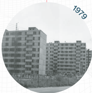
Výstavba sídliště Pod oborou
