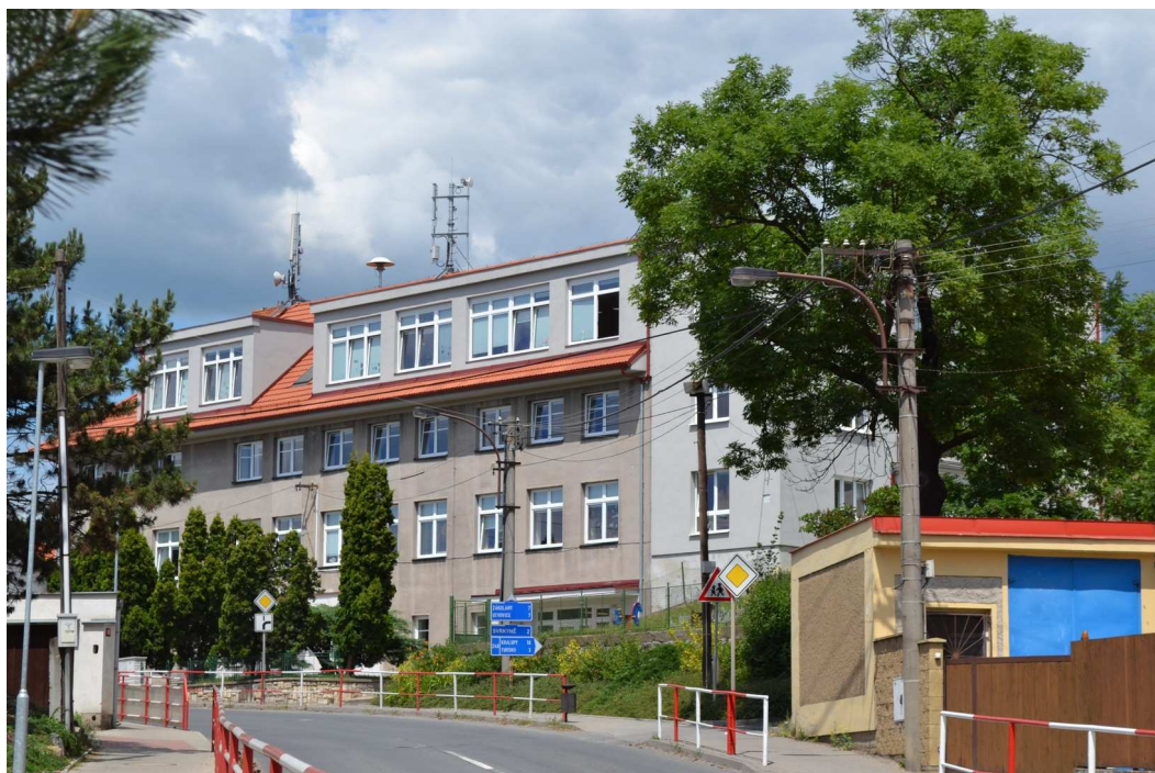
Dokončené 4. podlaží na staré budově ZŠ
