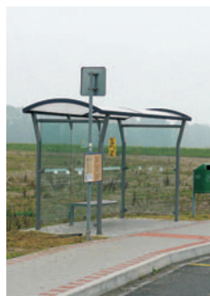
Autobusová zastávka ve Vlčovicích.
