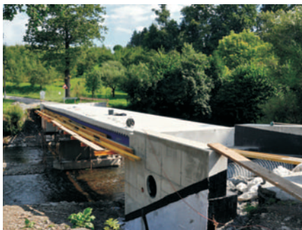
Stavba mostu „Na Habeši“.
