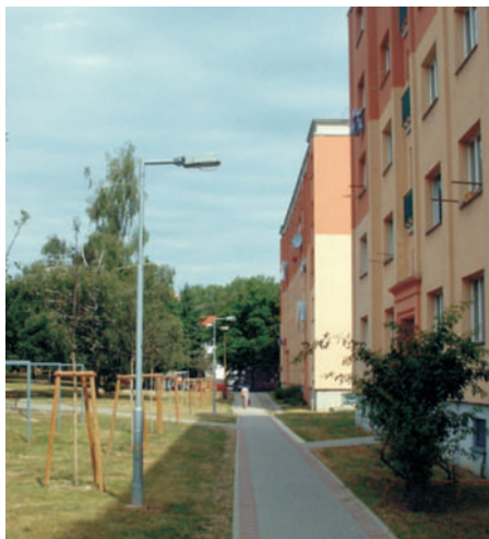
Rekonstrukce chodníků a veřejného osvětlení.
