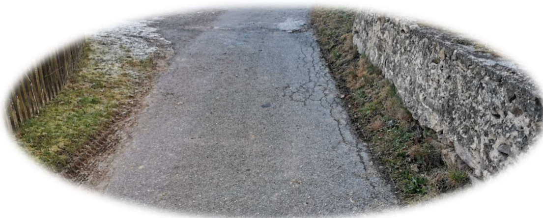
Obrázek 7: Čepřovice, místní komunikace
