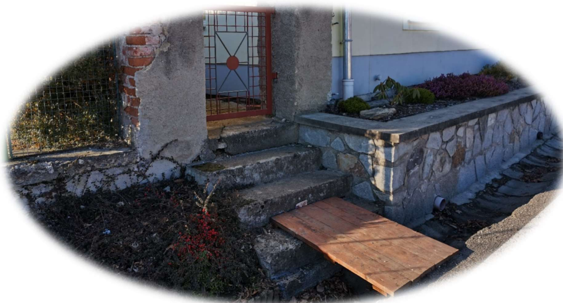
Obrázek 14: Čepřovice, mateřská škola, schodiště
