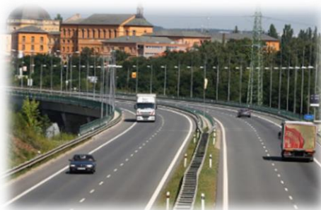
Obr 8 Dálniční přivaděč k D5
