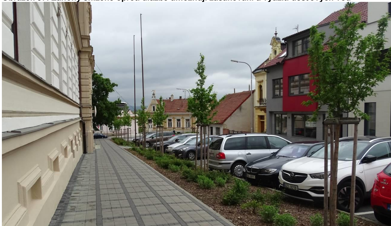
Obrázek 57: Záhony snížené oproti dlažbě umožňují zasakování a využití dešťových vod
