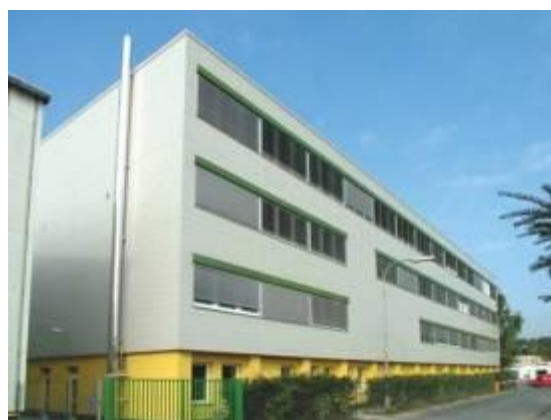
Odvětratelná fasáda ve světlém provedení (zdroj: www.konstrukce.cz )
