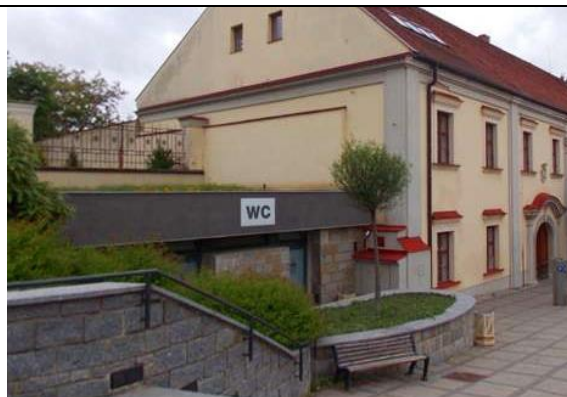
Extenzivní zelená střecha na budově veřejných toalet v Uherském Brodě (zdroj: www.ub.cz )
