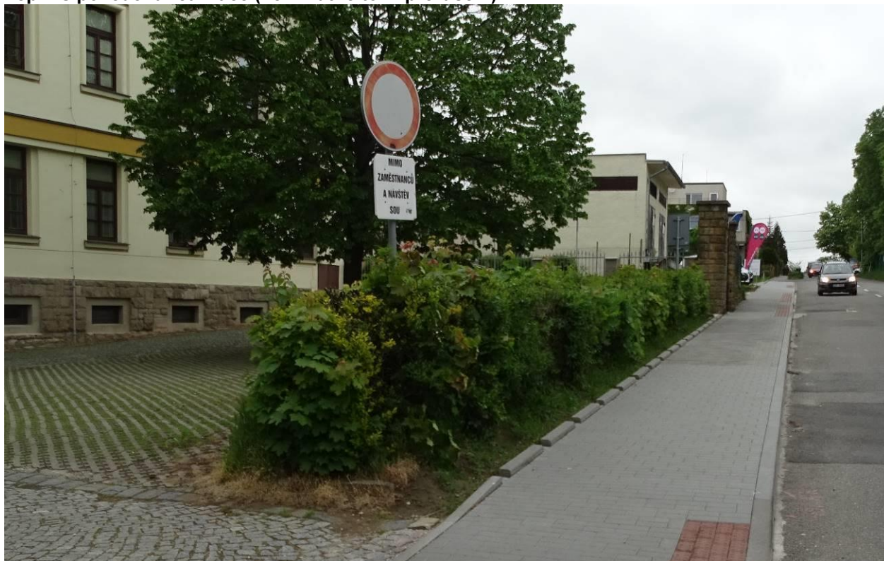
Obrázek 56: Přerušené obrubníky – umožňují části vod zasáknout do zeleně, avšak esteticky nepříliš povedená realizace (není nutné tolik přerušení).
