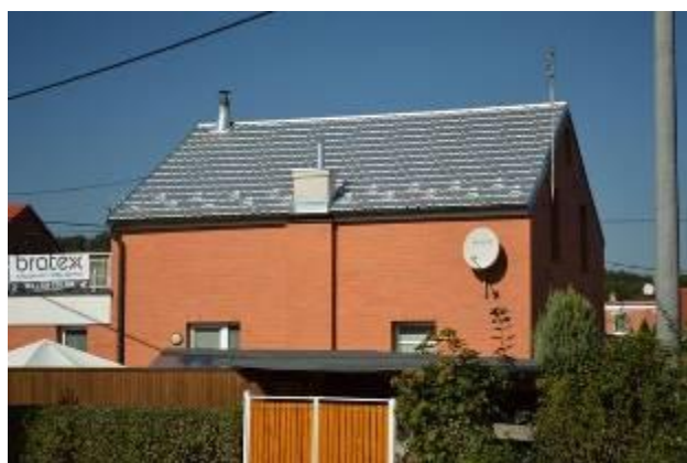
Bílá kovová střecha české produkce (zdroj: www.krytiny-strechy.cz )
