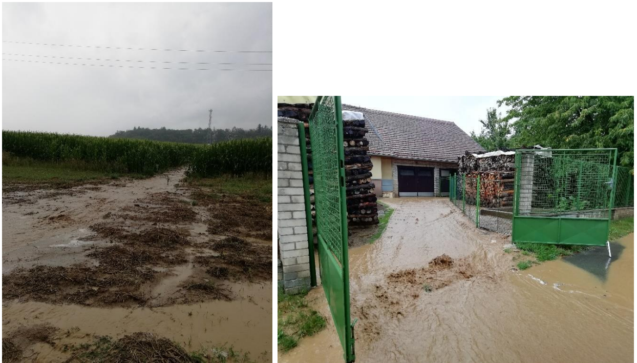
Obr. 161 Přívalová povodeň - 27. 7. 2019 škody na zemědělských plochách, majetku obyvatel a místních komunikacích
