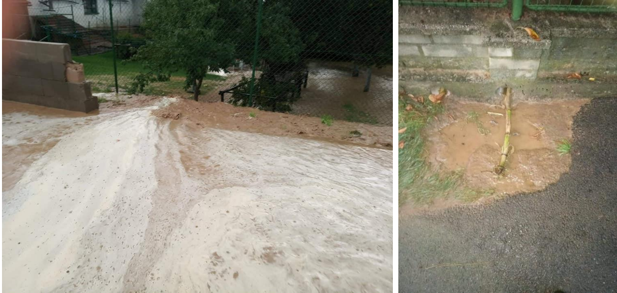
Obr. 17 Přívalová povodeň 26. 8. 2019 – zanesení místních komunikací a kanalizace splachy z polí, zaplavení majetku obyvatel
