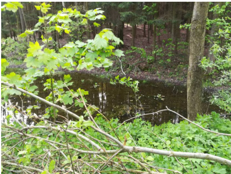
Obr. 144. Zanešená a nefunkční stávající nádrž VN2 - Suchá
