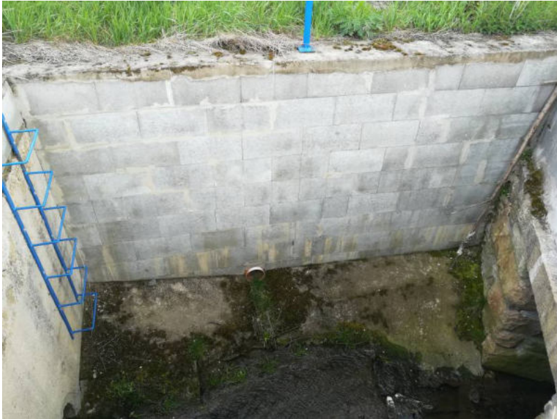
Obr. 151. Přepadová šachta nad drážním tělesem
