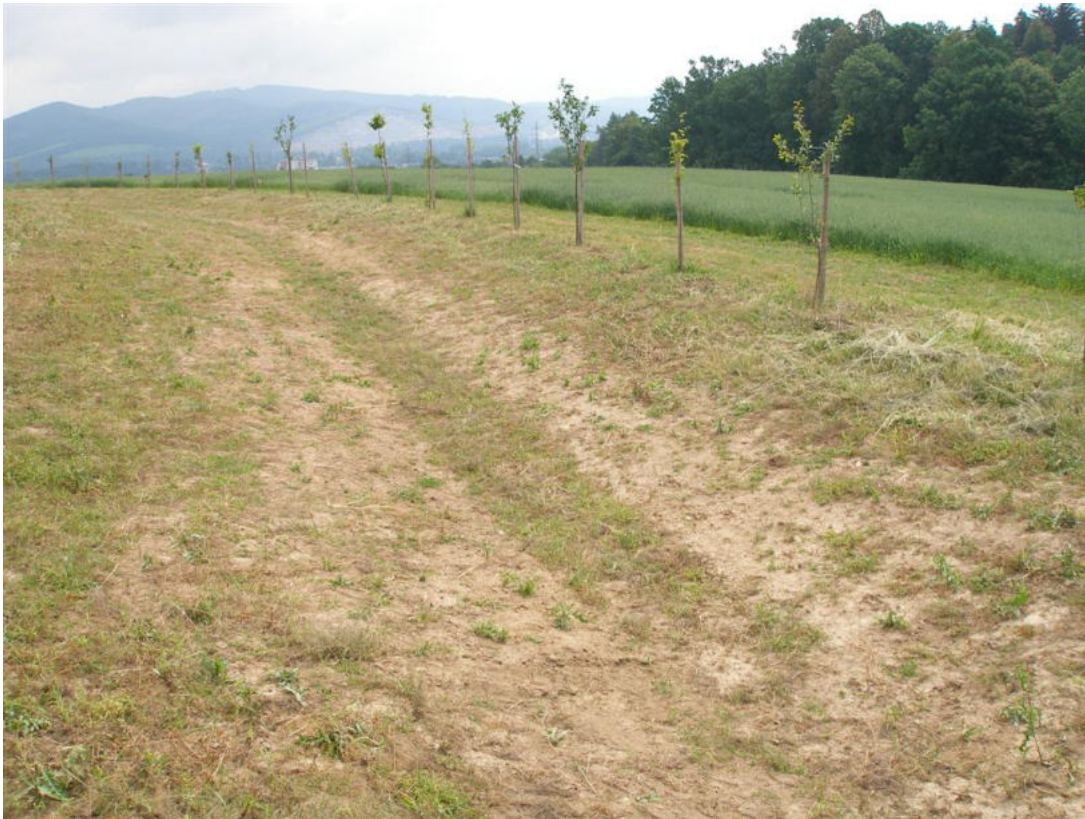
Obr. 100. Ukázka možné podoby zatravněného průlehu
