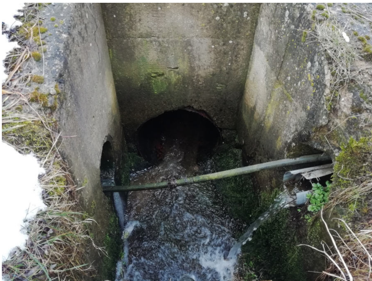
Obr. 73. Fotografie kritického bodu KB 24 – trubní propustek v místě KB 24b
