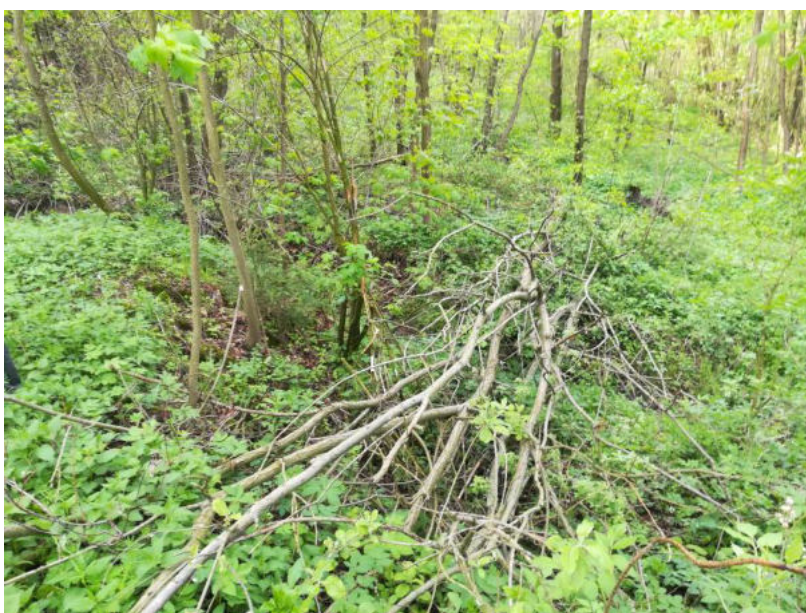
Obr. 145. Protržená hráz nádrže VN2 - Suchá
