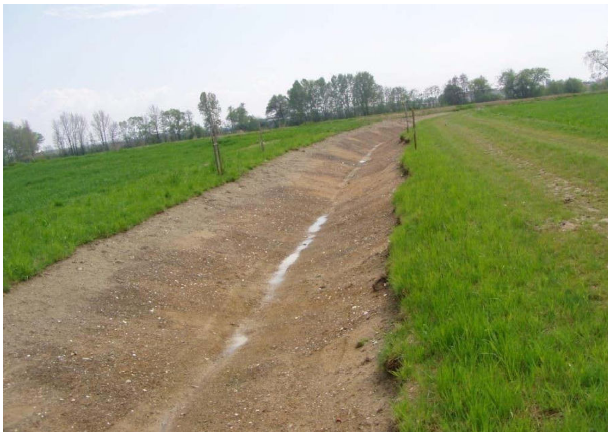
Obr. 99. Ukázka možné podoby nově zrealizovaného zatravněného průlehu
