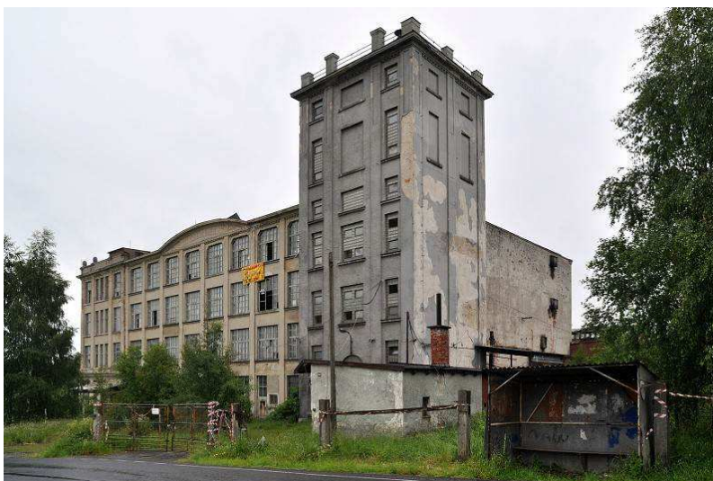
Obr. č. 30: Objekt bývalé továrny v Libě
