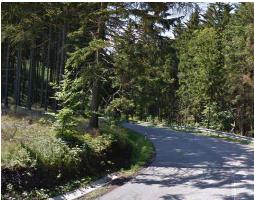
Foto 3 - Silnice III/2784 - směrový oblouk ve staničení 13,212 km (varianta I.)
