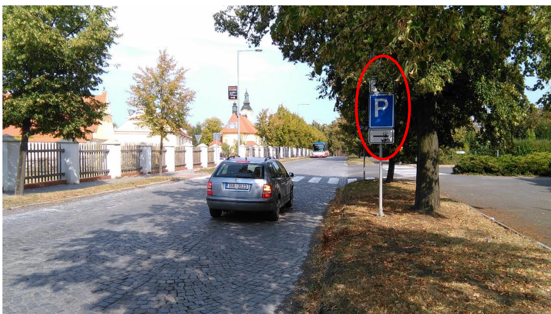
Obr. 14 Zarostlé svislé dopravní značení v ulici Pražská – parkoviště u Polikliniky vpravo, není vůbec vidět značka P+R, šipka vlevo
