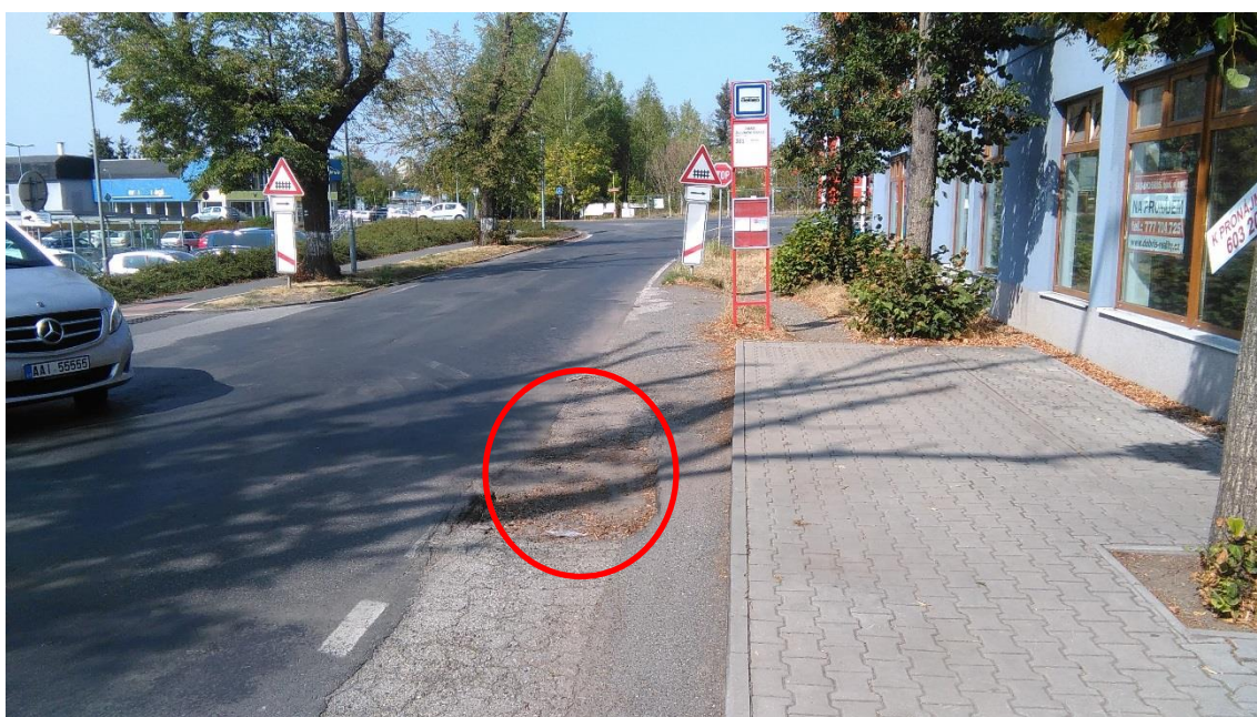
Obr. 12 Díry v komunikaci u autobusové zastávky Dobříš, železniční stanice (ulice Kninská)
