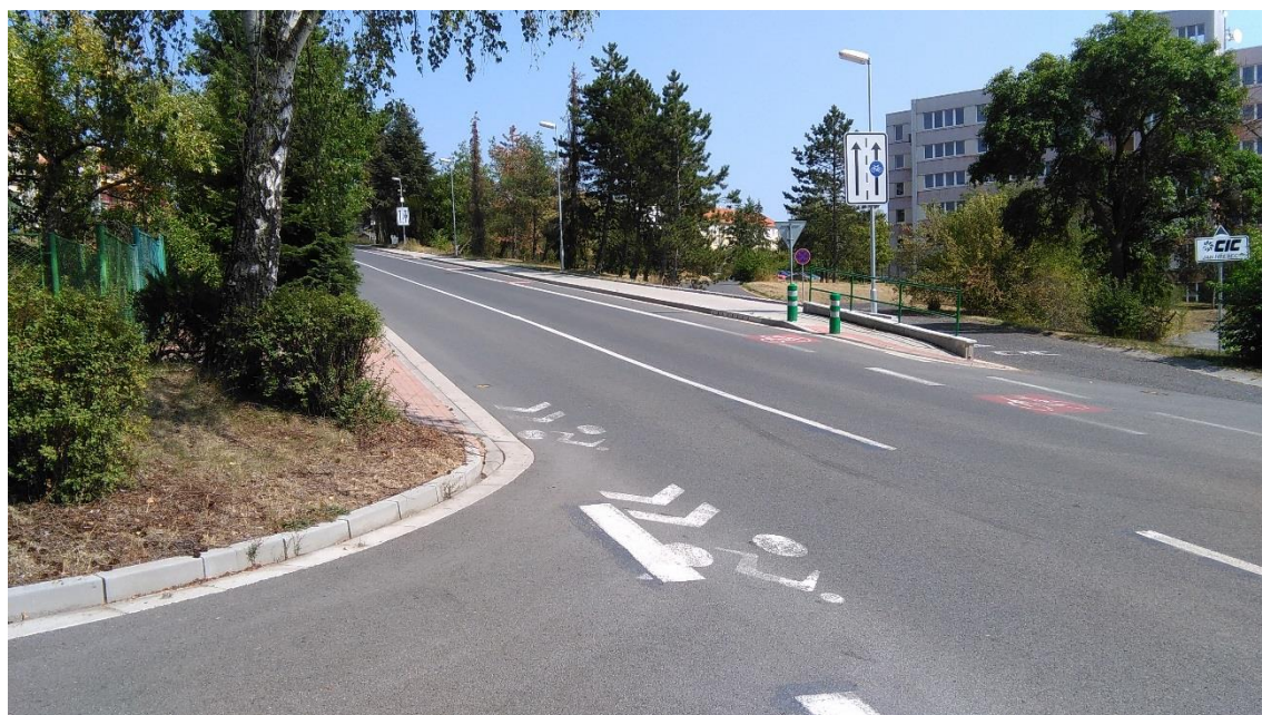
Obr. 5 Nedostatečný rozhled z ulice Jasmínová na hlavní komunikaci Rukavičkářská
