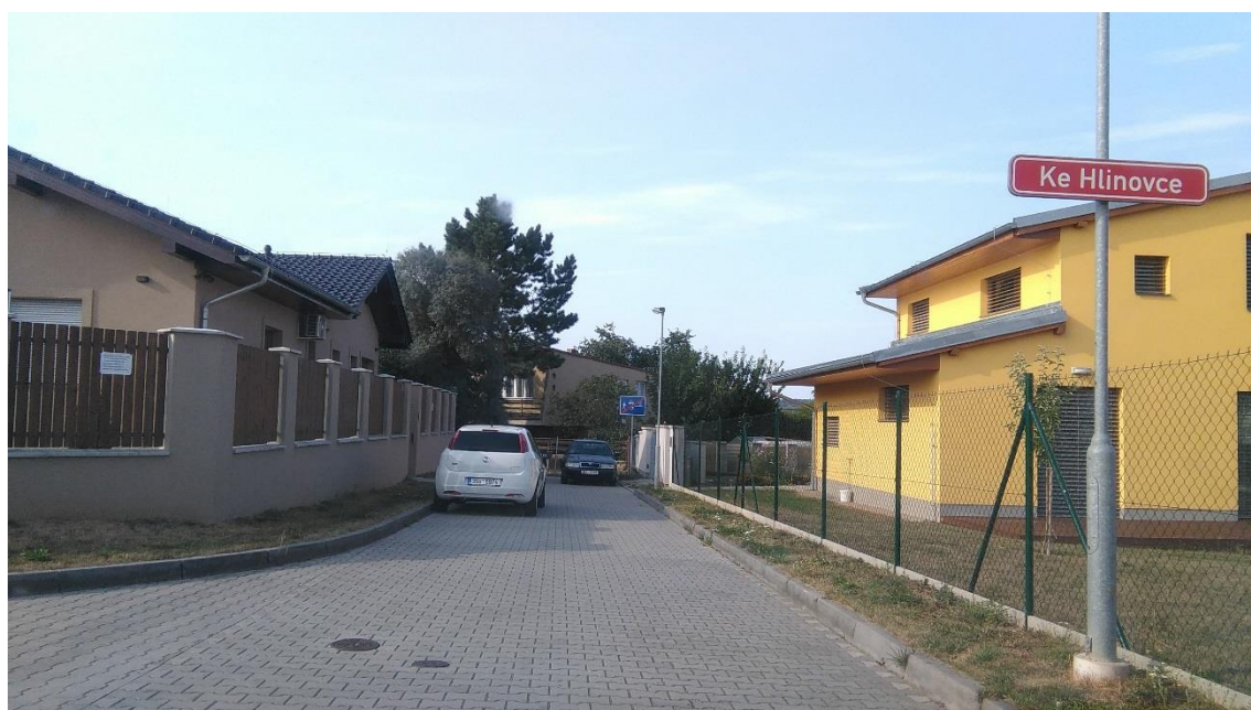
Obr. 6 Obytná zóna v ulici Jiráskova a Ke Hlinovce nemá parametry obytné zóny – jedna výšková úroveň, parkování dovoleno jen na vyznačených parkovacích stáních
