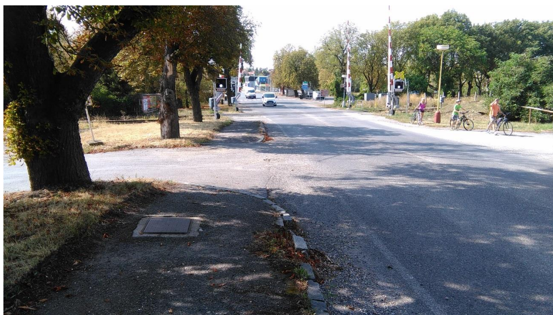
Obr. 18 Chodníky v ulici Pražská (severní části) ve velmi špatném technickém stavu
