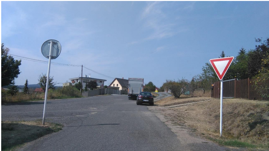
Obr. 1 Rozlehlá křižovatka ulic Nad Papežem – K Vodárně, nevhodný úhel napojení
