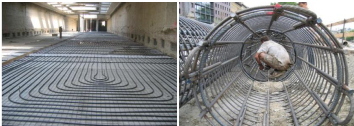
Obrázek 16: Nahoře vlevo - Kolektor v základové desce; nahoře vpravo - instalace kolektoru do ocelové výztuže pilotů; dole – řez typickým provedením stanice
