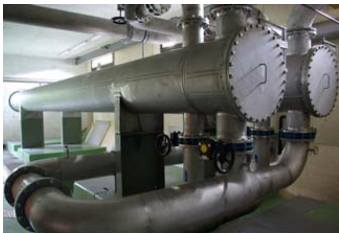
Obrázek 36: Výměník tepla v ČOV v Bernu (Zdroj: Huber CS)
