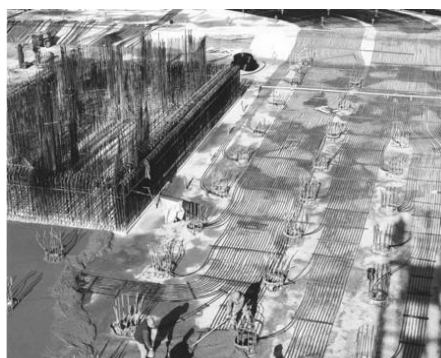
Obrázek 15: Vlevo - Mapa rozšíření trasy U2, červeně vyznačeny stanice, v nichž se využívá geotermální energie; vpravo - záběr na kolektory položené do betonových základů stanic
