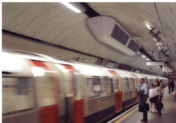
Obrázek 25: Vizualizace navržené tzv. staniční vzduchotechnické jednotky (výměník vzduch/voda) zajišťující dochlazování prostor metra.
