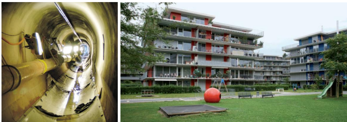
Obrázek 33: Vlevo: Instalace výměníku tepla na dně kanalizační stoky z Wässerwiesenu; Vpravo: obytná zástavby čtvrti Wässerwiesen (Zdroj: EBM)
