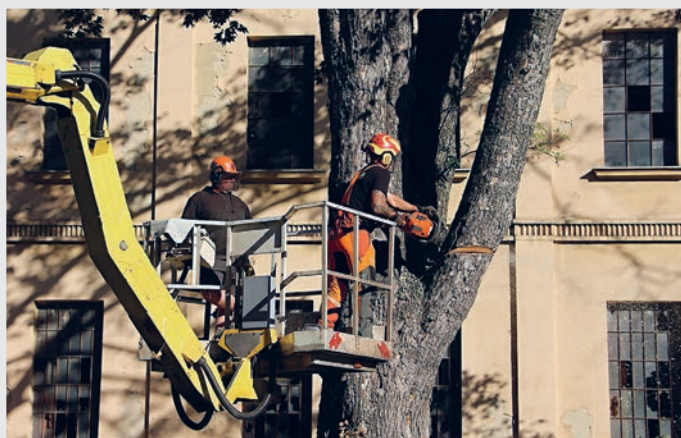
Na náměstí Míru ve středu 12. září specializovaná firma z bezpečnostních důvodů odstranila javor. Odbor životního prostředí k tomuto rozhodnutí vedly výsledky tahových zkoušek, které potvrdily špatný stav stromu.
