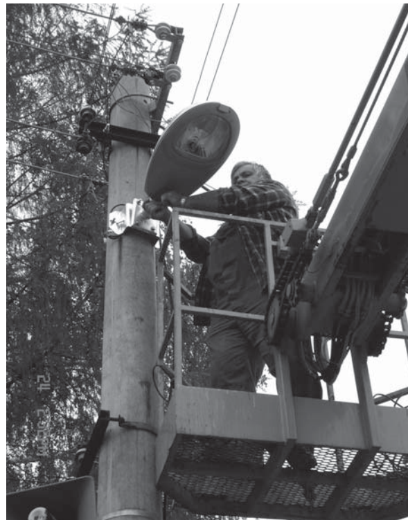
Obrázek 7 | Montáž nového veřejného osvětlení v Hostětíně | Zdroj: Archiv ZO ČSOP Veronica
