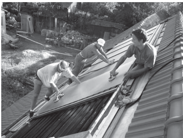
Obrázek 2 | Montáž solárního kolektoru na střechu moštárny v srpnu 2001 | Zdroj: Archiv ZO ČSOP Veronica
