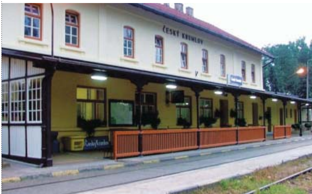
NA SNÍMKU NÁDRAŽÍ V ČESKÉM KRUMLOVĚ, KDE BYL POSTAVEN POHODLNÝ BEZBARIÉROVÝ VSTUP DO NÁDRAŽNÍ HALY.
