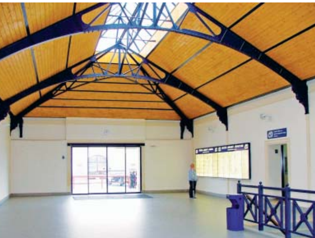
VELMI ESTETICKY A BEZBARIÉROVĚ REKONSTRUOVANÁ PŘÍJEZDOVÁ HALA V ŽELEZNIČNÍ STANICI LIBEREC.
