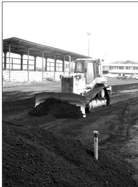
Probíhá skrývka škvárového povrchu.
