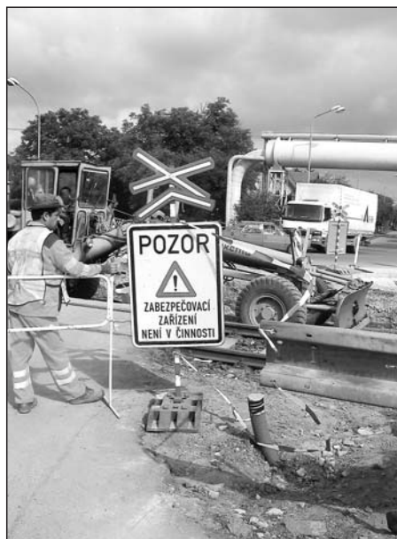
Přejezd u mlékárny prochází rekonstrukcí.
