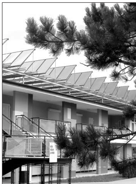
Solární panely na střeše provozní budovy.
