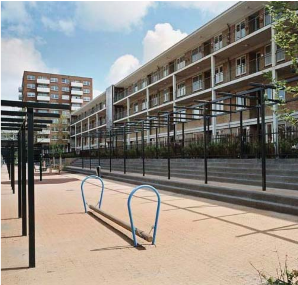
sídlíště Enschedelaan, Den Haag, NL
