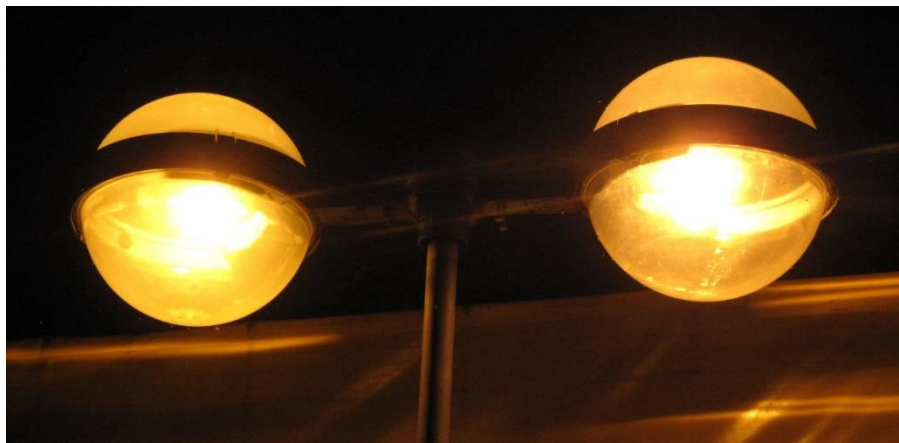
Obrázek 10 Rušivé světlo z necloněného svítidla s vyzařováním světelného toku do horní poloviny (foto Theodor Terrich)
