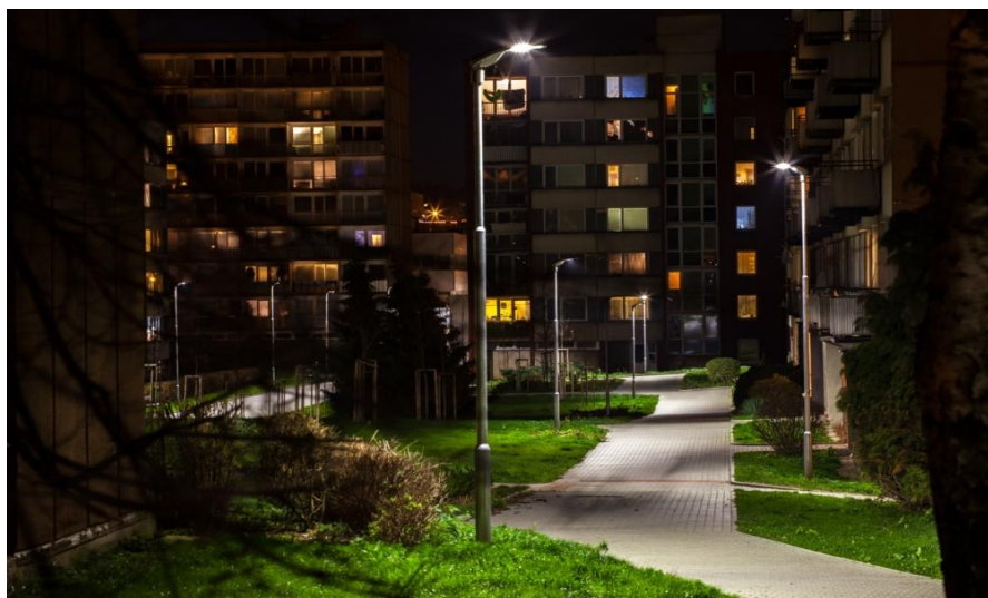
Obrázek 16 Soustava veřejného osvětlení s LED omezuje vyzařování světelného toku do horního poloprostoru, minimalizuje dopady rušivého světla (zřetelné u stožárů v pozadí fotografie) (foto: ETNA s.r.o.)
