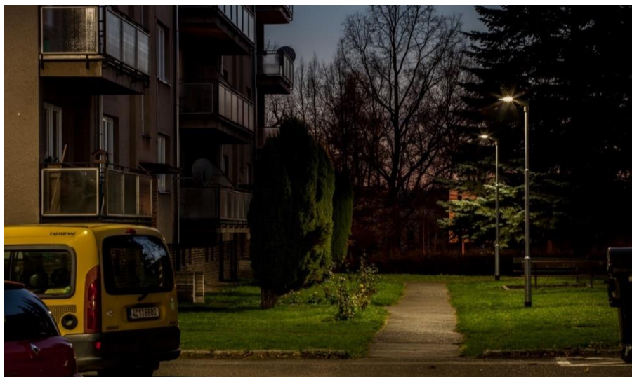
Obrázek 14 Svítidla moderního VO směřují světelný tok do dolního poloprostoru. (foto: ETNA s.r.o.)
