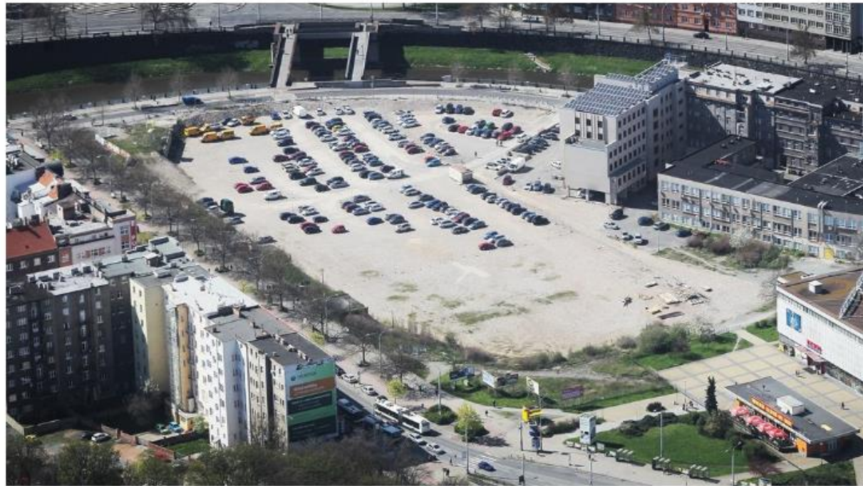
Plocha po zbouraném Domě kultury Inwest v Plzni. | foto: Ladislav Němec, MAFRA
