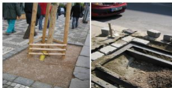
realizace otevřeného povrchu stromové mísy a instalace mříže
