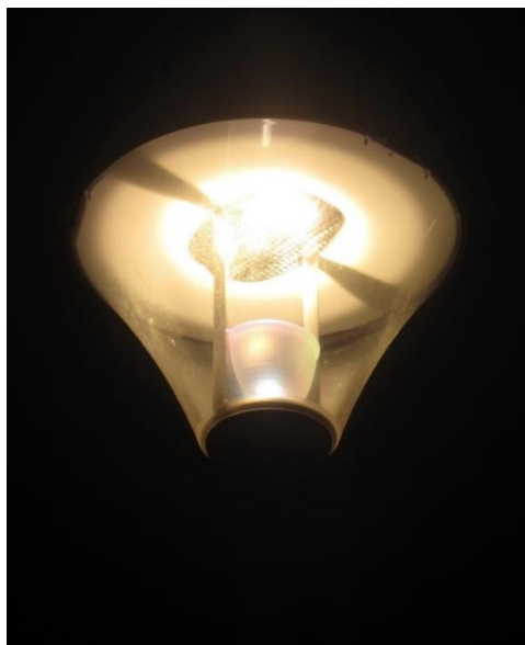
Obrázek 6 Parkové svítidlo osazené reflektorovou halogenidovou výbojkou (foto: Theodor Terrich)
