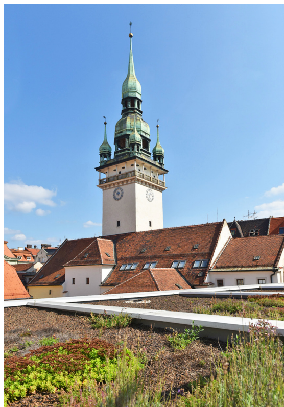
Zelená střecha na Tržnici Brno
