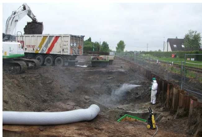
Odtěžení bývalé skládky odpadu, Buggenhout, Belgie © Public Waste Agency of Flanders
