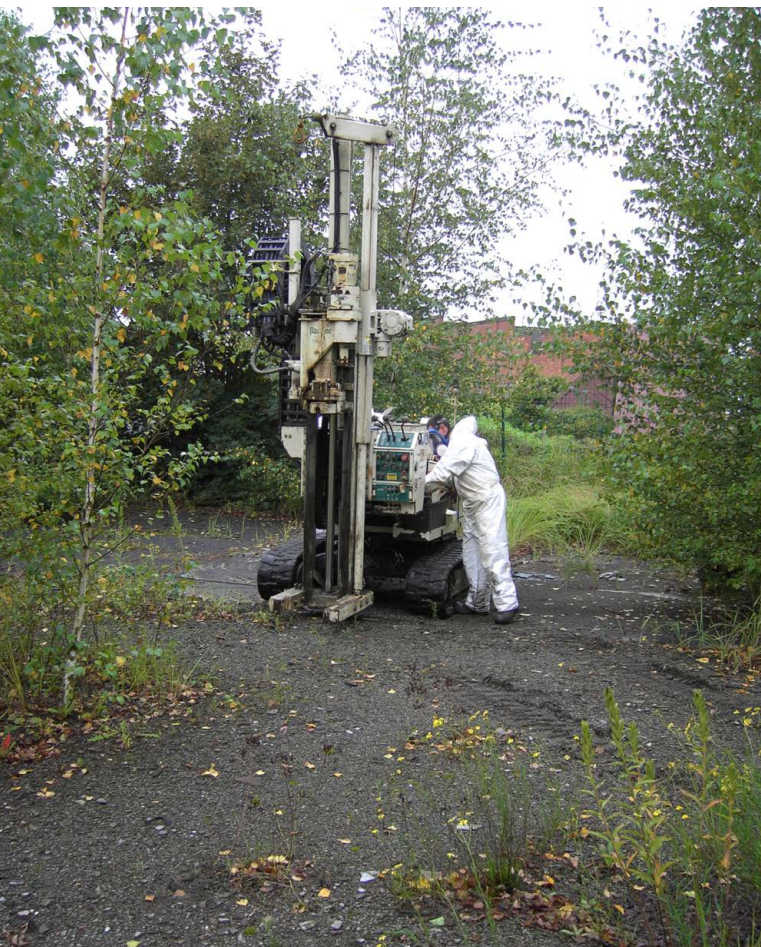
Geologický průzkum lokality v kontaminované lokalitě v Lokerenu, Belgie © Public Waste Agency of Flanders
