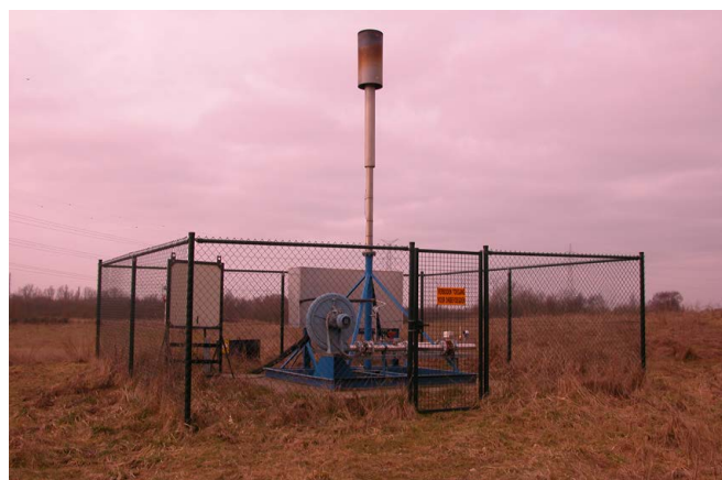
Odplynění bývalé skládky, Schelle, Belgie © Public Waste Agency of Flanders
