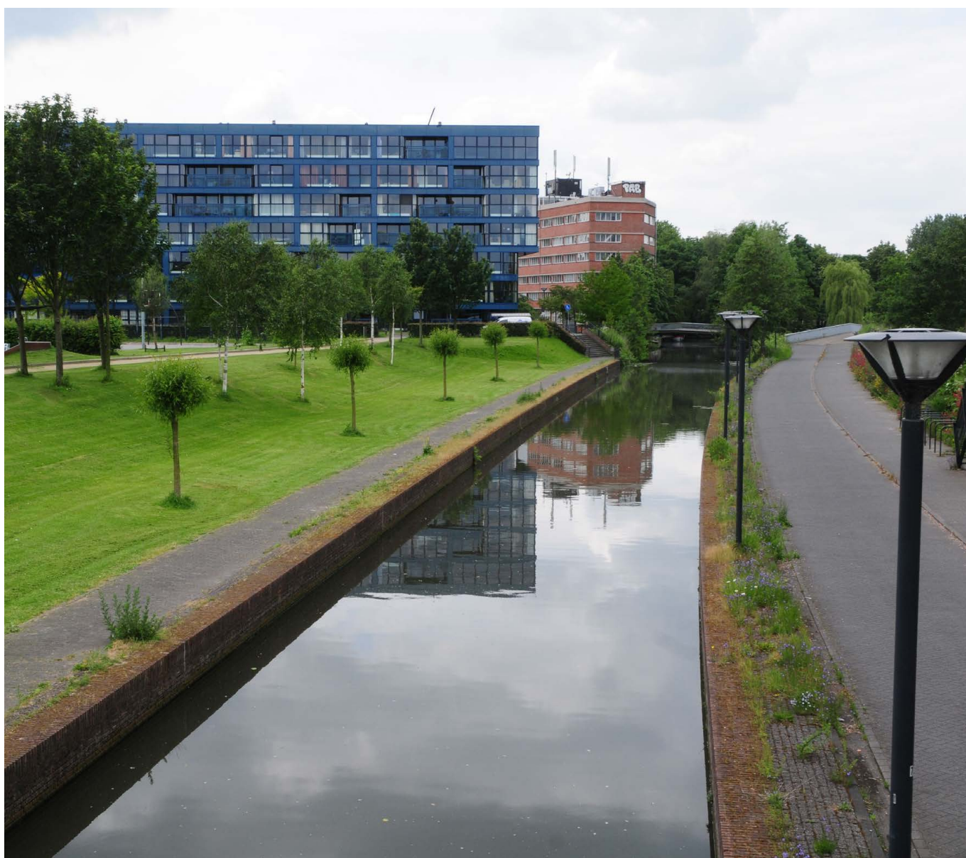
Griftpark v Utrechtu, Nizozemsko po sanaci závodu na výrobu plynu © V.M. Lansink
