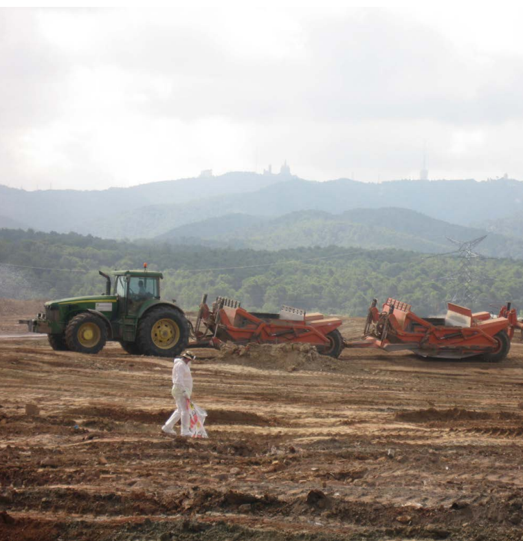
Sanační práce a opatření k eliminaci expozice azbestu v Parc de l'Alba, Španělsko © Parc de l'Alba
